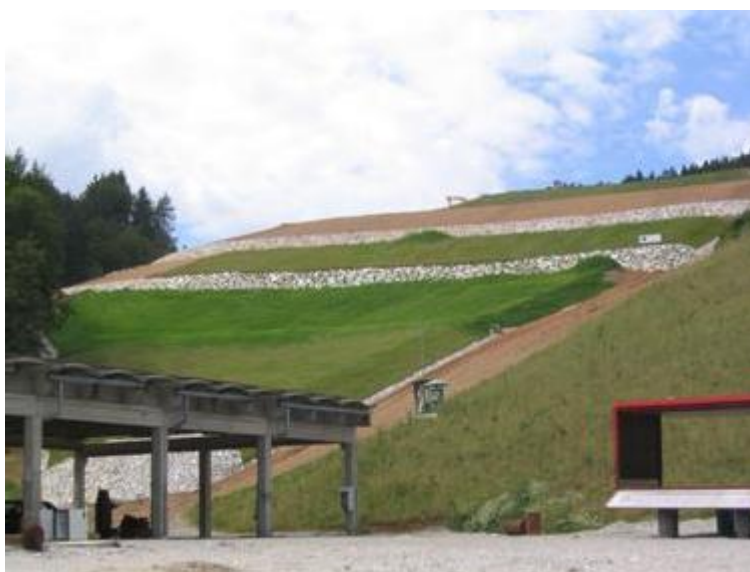
Slika 1: Jalovišče Jazbec po končani sanaciji ( http://www3.fgg.uni-lj.si/... , 30. 8. 2011).
