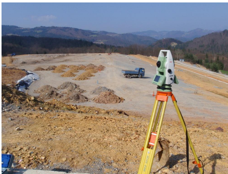
Slika 5: Sanacija odlagališča HMJ Boršt, nanos prekrivke, 2009.
