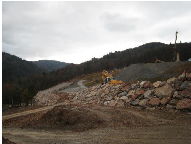
Slika 3: Končno urejanje severne brežine odlagališča HMJ Boršt ( http://www3.fgg.uni-lj.si/... , 30. 8. 2011).
