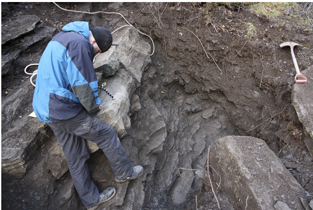
Slika 19: Območje kjer bo postavljen temelj na desni strani soteske
