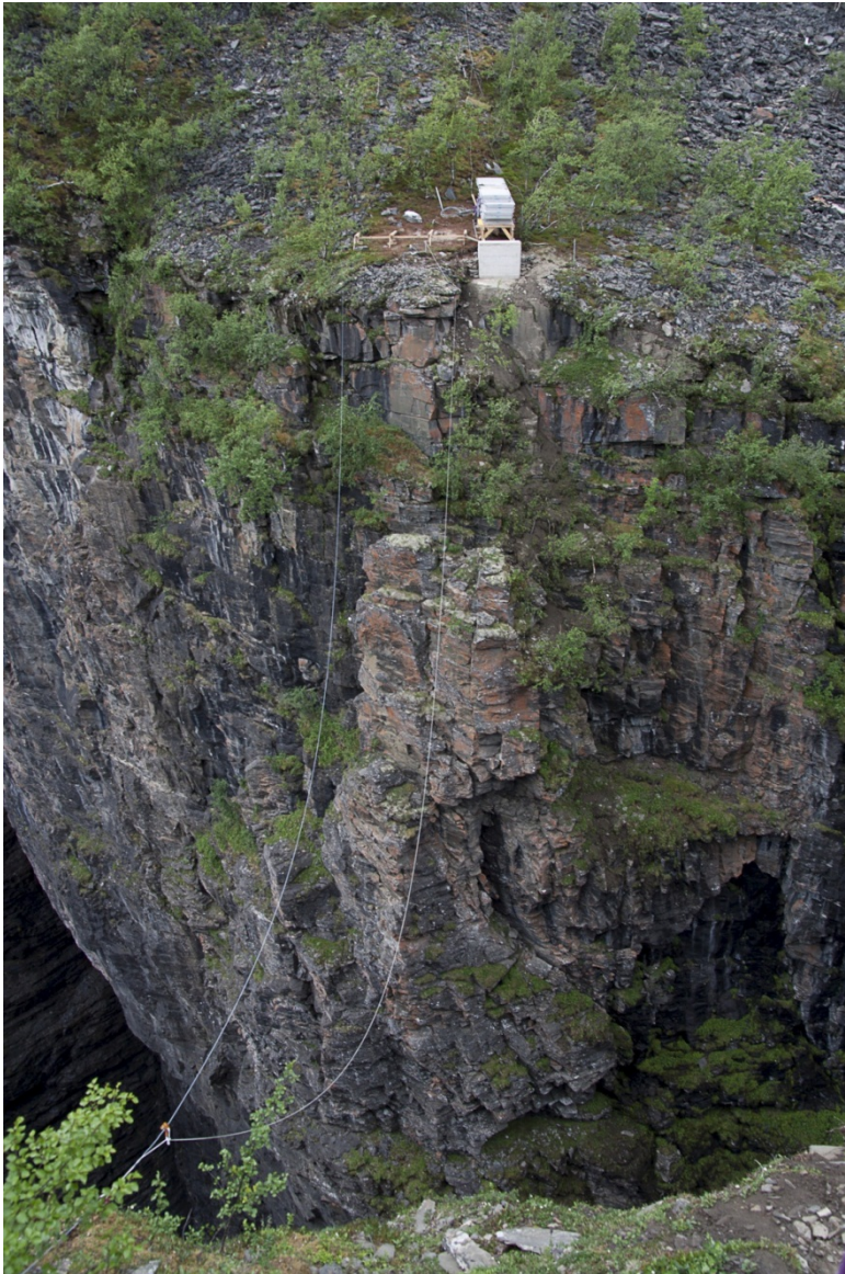
Slika 15: Leva stran soteske z že izvedenim temeljem
