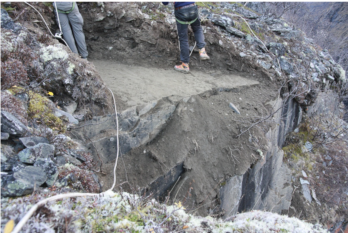
Slika 17: Leva stran soteske in mesto temelja po odstranitvi kamnitih nanosov
