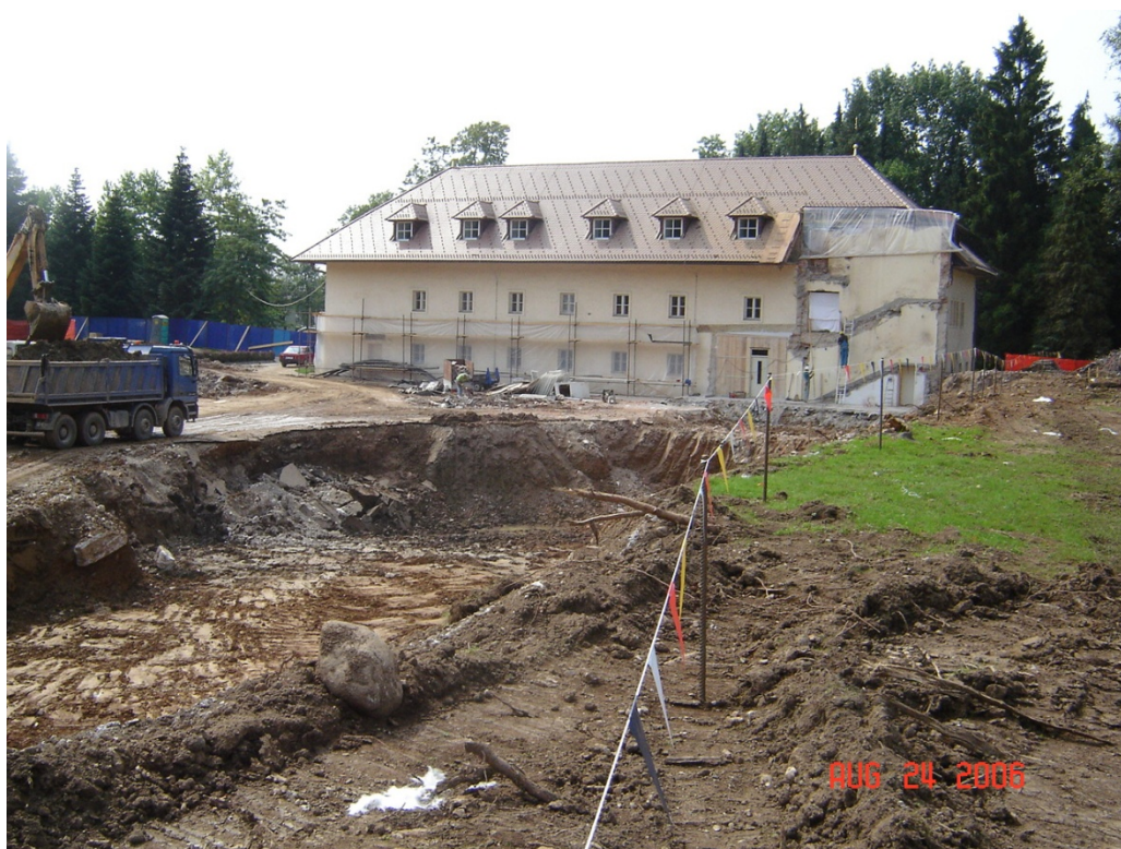
Slika 2: Zoisova pristava in gradbena jama na mestu rušenja objekta
