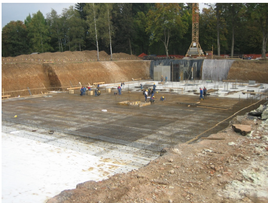
Slika 3: temeljna plošča
