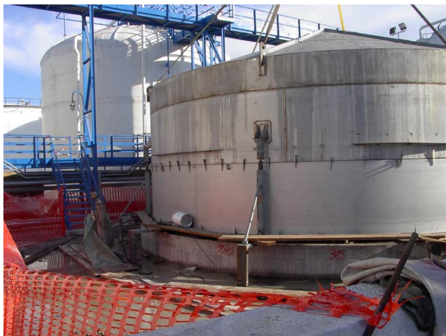
Slika 24: Gradnja rezervoarja – namestitev podpornih stebrov
