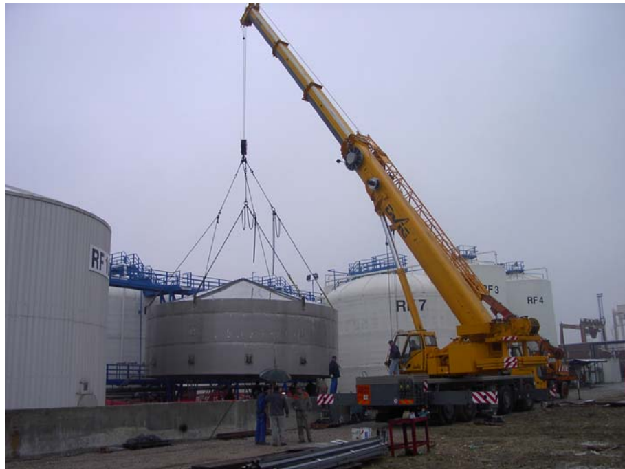
Slika 25: Gradnja rezervoarja – dvigovanje četrtega, petega in šestega ovoja ter strehe za namestitev podpornih stebrov
