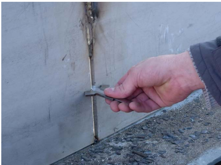
Slika 39: Kontrola priprave zvarnega spoja
