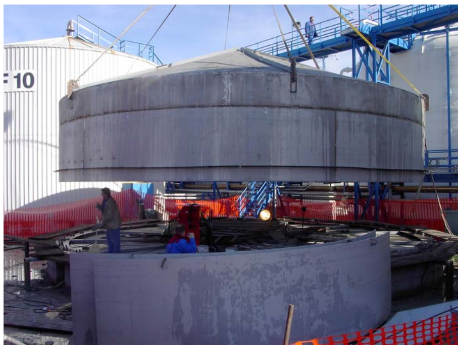
Slika 23: Gradnja rezervoarja – dvigovanje petega in šestega ovoja ter strehe
