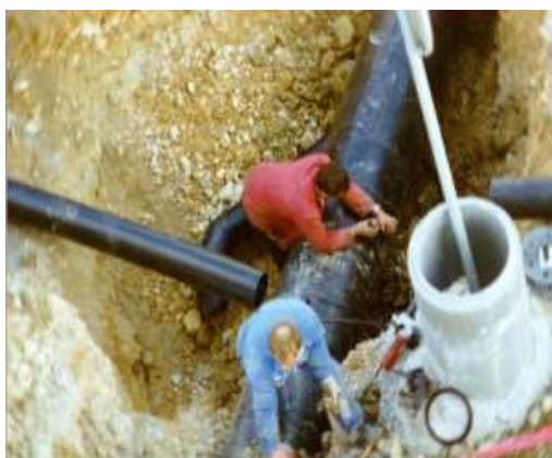
Slike vgrajevanja kanalizacijskih cevi ( http://www.minerva.si/ )
