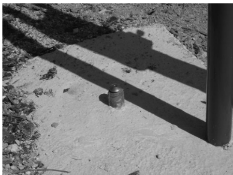
Slika 3: Stabilizacija talnega reperja z možnostjo postavitve stativa
