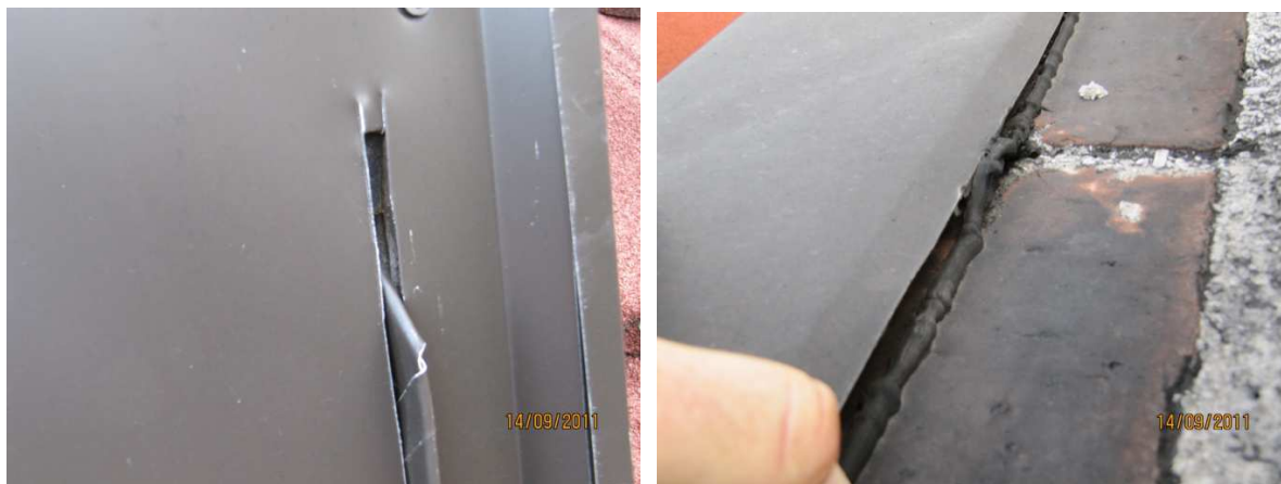
Slika 41: Neustrezna izvedba detajlov pri pločevinasti obrobi obstoječega dimnika
