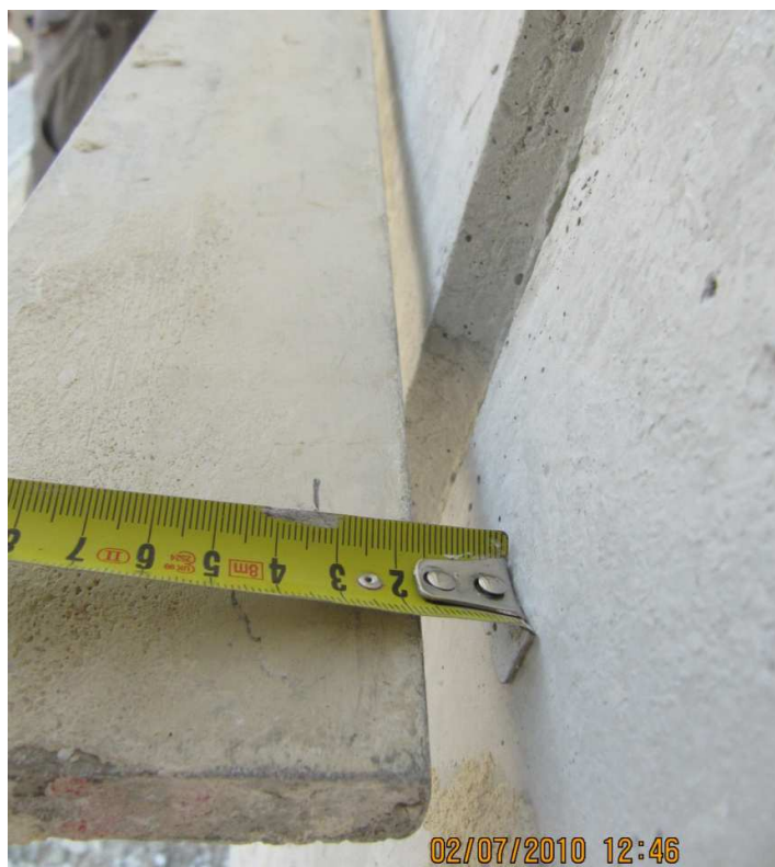
Slika 23: Kontrola ukrivljenosti AB fasadnih plošč
