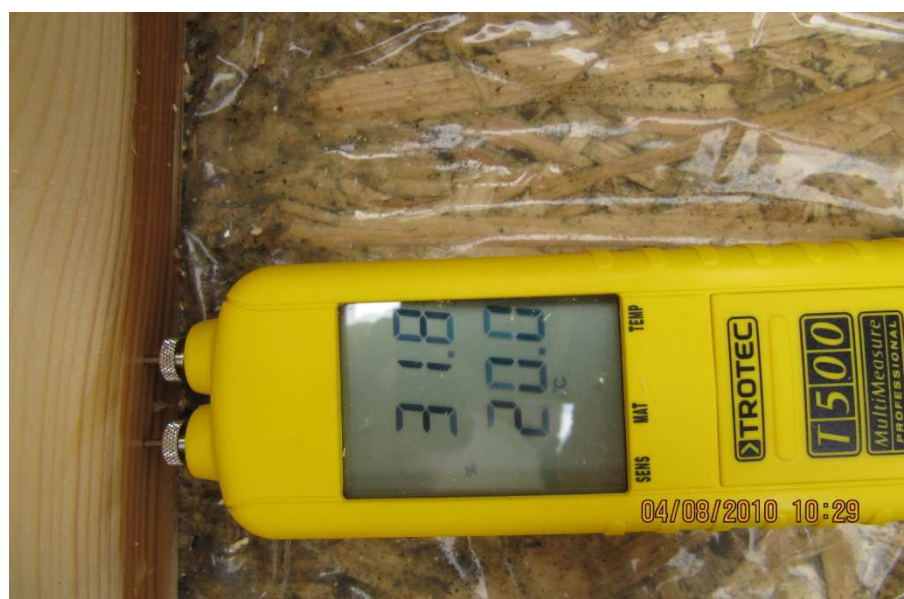
Slika 21: Meritev vlage v leseni strešni konstrukciji
