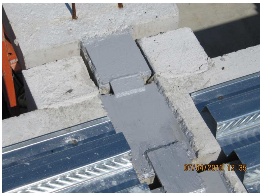
Slika 4: Stikovanje nosilcev z jekleno ploščo
