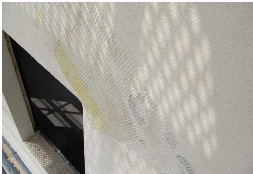
Slika 6: Izvedba diagonalnega armiranja pri tankoslojni fasadi
