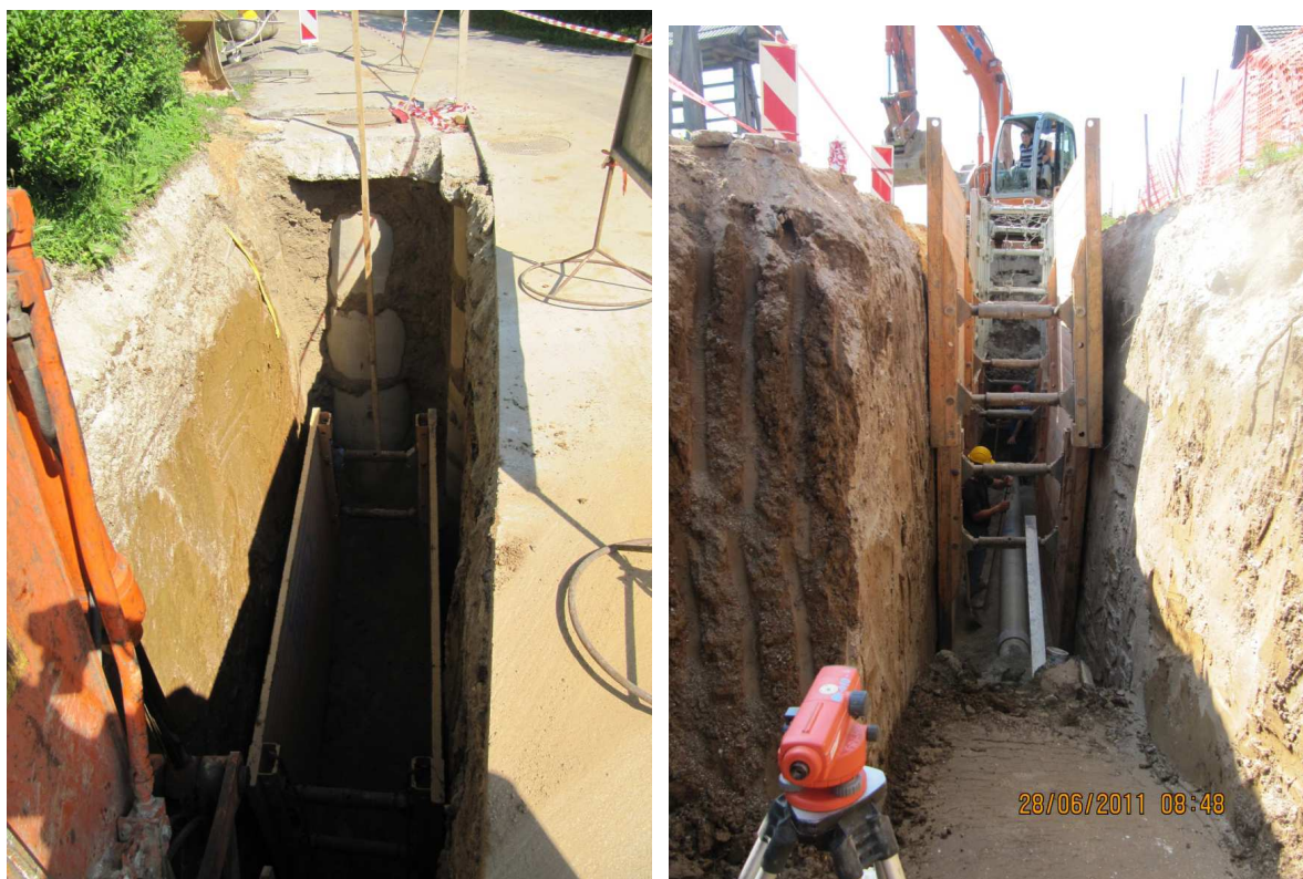
Slika 27: Zaščita brežine gradbene jame
