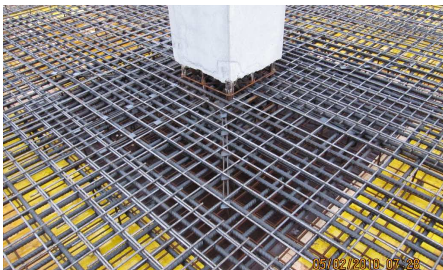
Slika 26: Armatura v plošči
