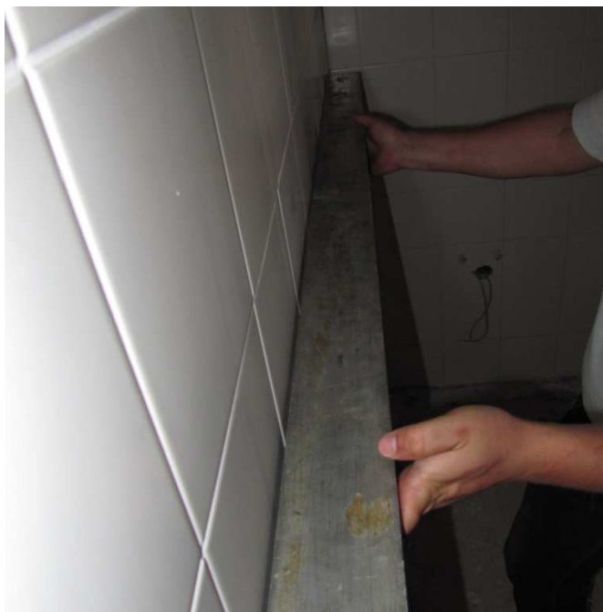
Slika 18: Kontrola ravnosti stenske keramike
