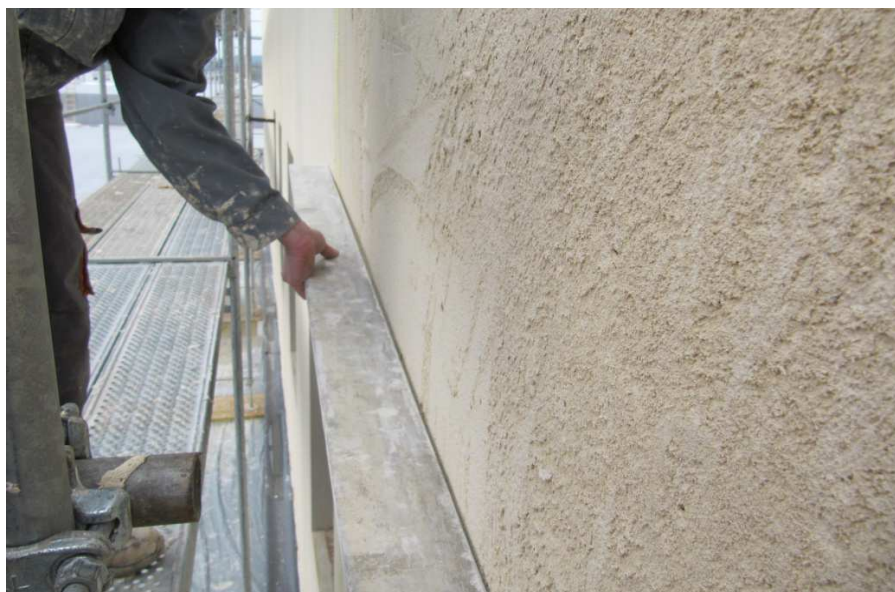
Slika 8: Kontrola ravnosti fasade: izvedba ustreza zahtevam standarda
