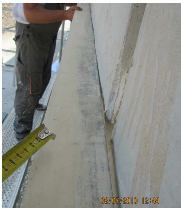
Slika 25: Neravnina AB fasadnih plošč
