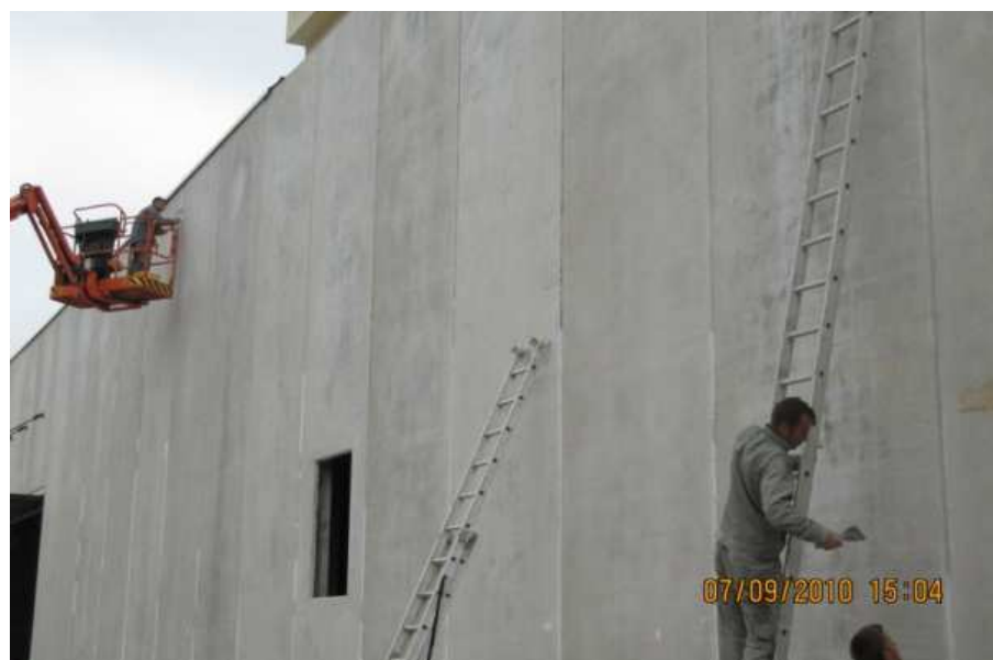
Slika 22: Sanacija fasade s specialno malto
