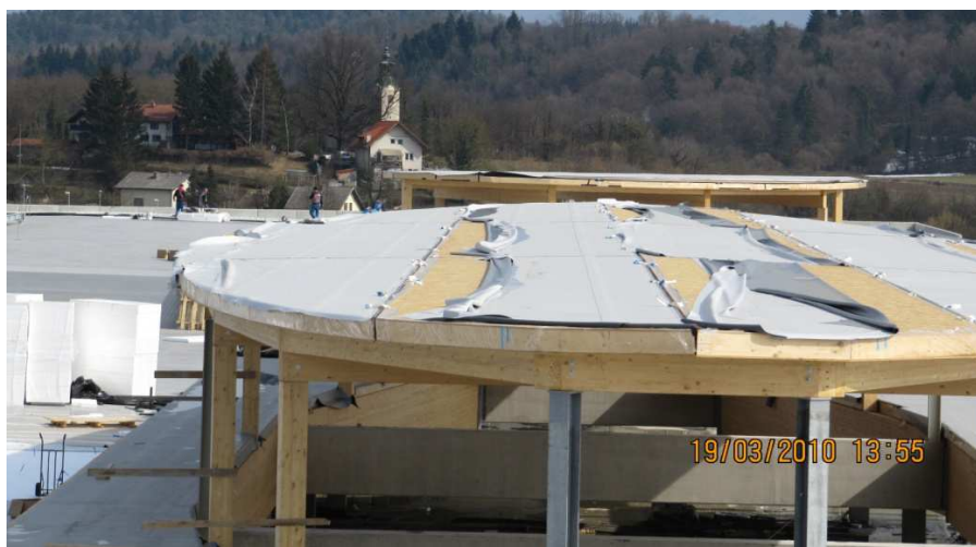
Slika 19: Lesena strešna konstrukcija trgovskega objekta
