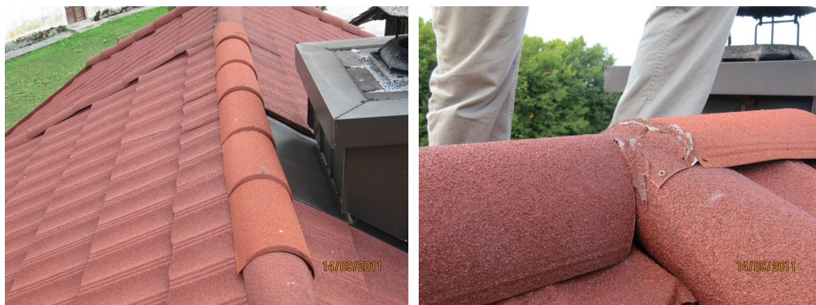
Slika 39: Uporaba slemenskih strešnikov različne barve z neustreznim višinskim zamikom
