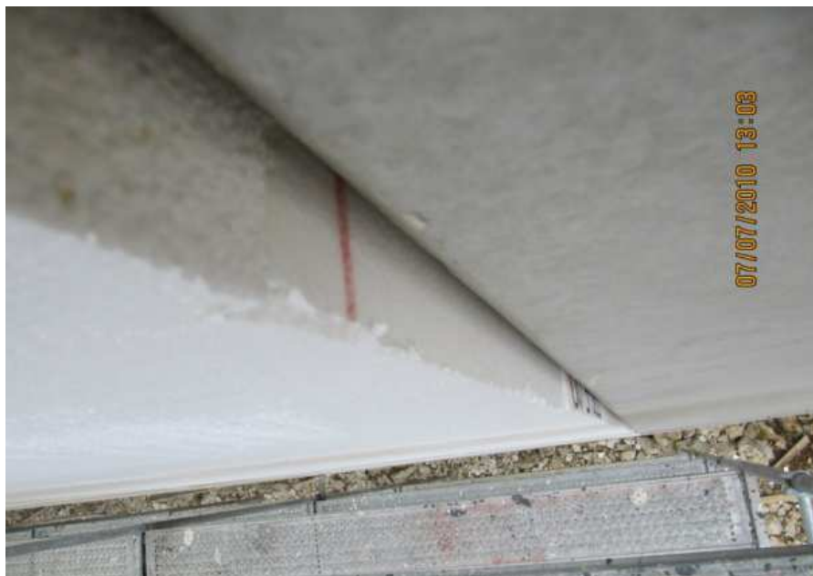
Slika 24: Ukrivljenost AB fasadnih plošč
