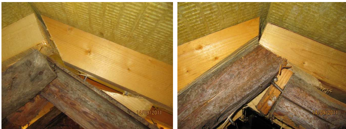
Slika 33: Napačna izvedba stikovanja špirovcev
