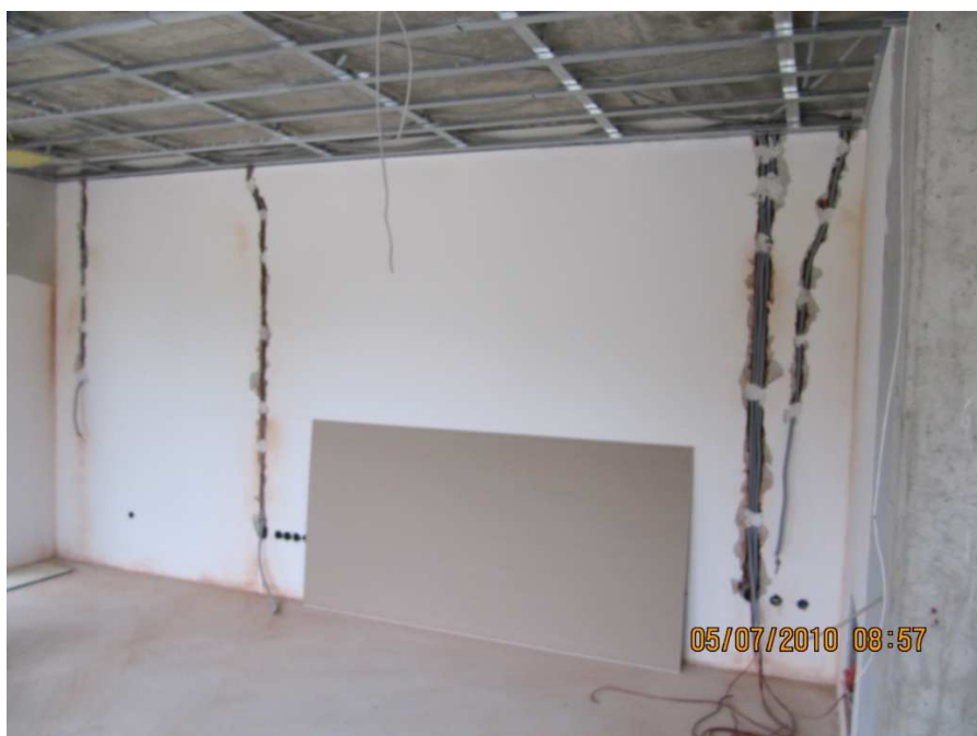
Slika 28: Dodatna napeljava električnih inštalacij
