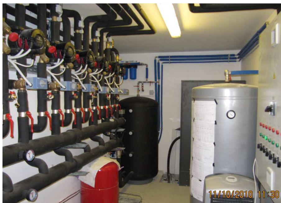
Slika 31: Izvedba strojnih inštalacij
