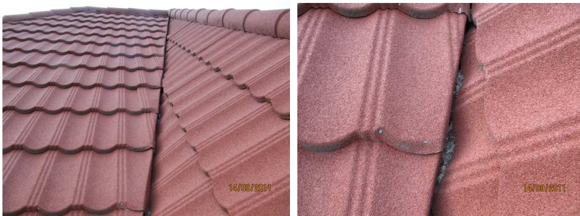
Slika 37: Nepravilno stikovanje strešne kritine v globelu strehe
