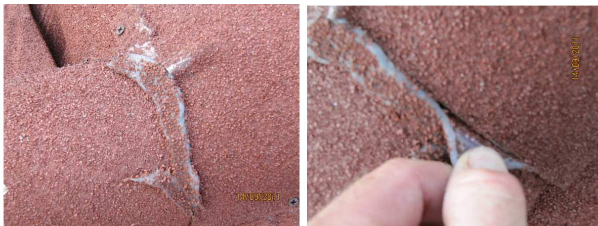
Slika 38: Nekakovostno izvedeni silikonski stiki v slemenu strehe
