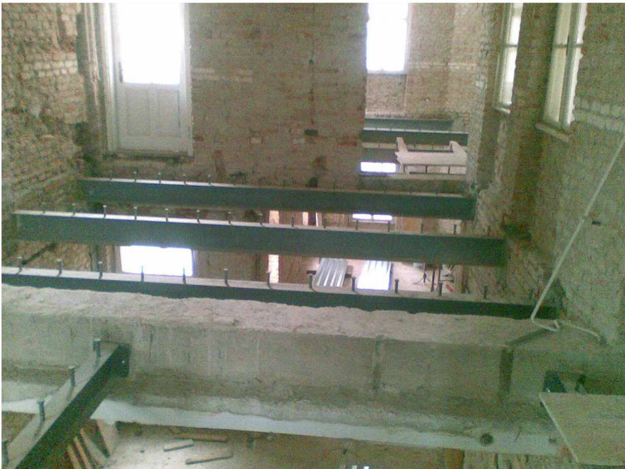
Slika 16: Na mestih starih lesenih tramov so se postavili novi jekleni z Nelson čepi in hi-bond pločevino.
