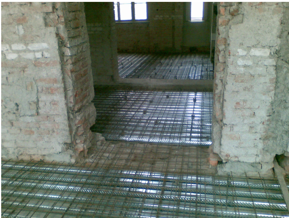
Slika 17: Armatura je bila položena na pločevino in sidrana v obstoječe nosilne zidove. V desnem spodnjem vogalu se vidi, da smo obstoječe jeklene poveznike nepoškodovane spustili na armaturo in vse skupaj zabetonirali.
