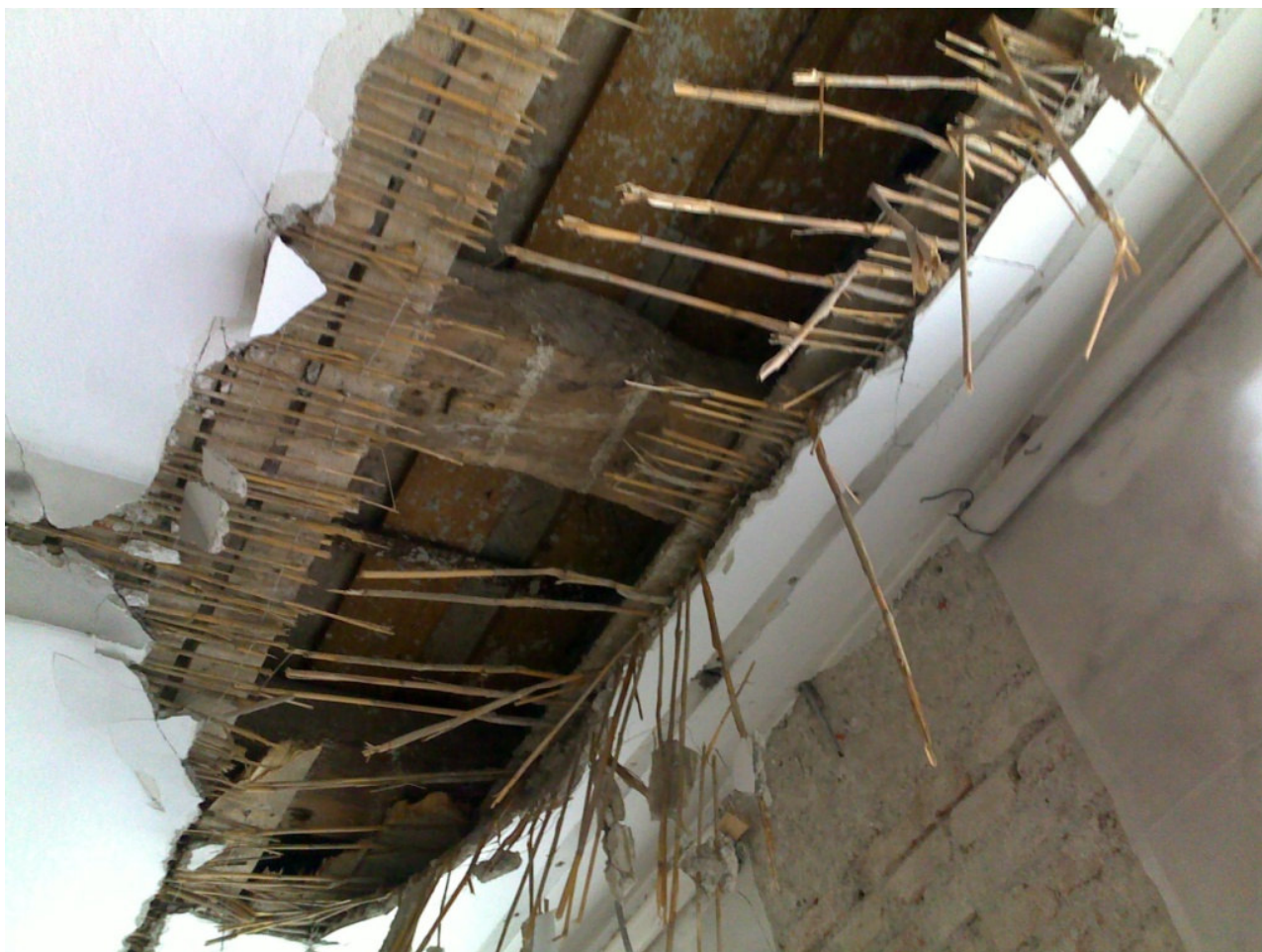
Slika 15: Obstoječi leseni strop, ki smo ga porušili in zamenjali.
