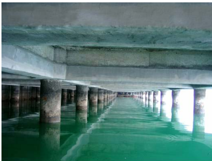
Slika 39: Dokončanje sanacije z reprofilacijo in zaščitnim premazom za beton
