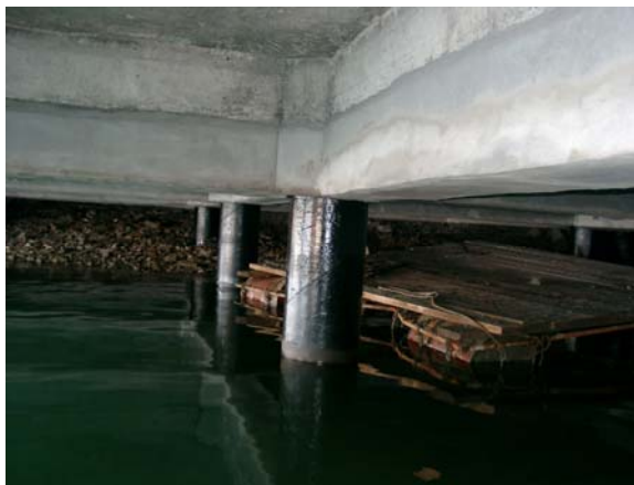
Slika 40: Zaščitni premaz na saniranih jeklenih stebrih
