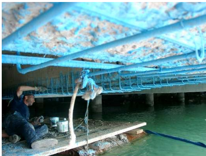
Slika 38: Protikorozijska zaščita očiščene obstoječe in dodane armature
