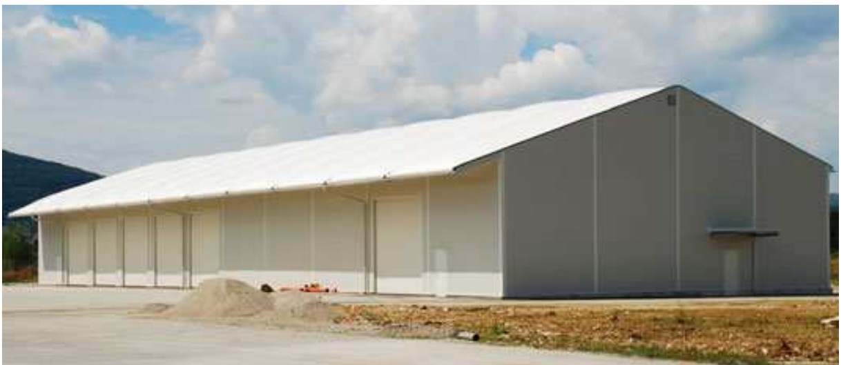
Slika 51: Skladiščni objekt s strešnim sistemom iz dvoslojnih pnevmatskih ponjav za skladiščenje proizvodov firme Michelin pred zaključkom gradnje, eden izmed mobilnih objektov, ki ga podjetje Loging oddaja v najem.
