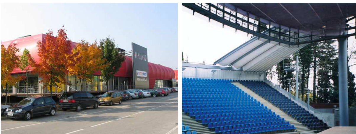
Slika 37: Rdeča membranska fasada Hale 12 v trgovskem centru BTC v Ljubljani (levo) in zložljiva pnevmatska membranska streha avditorija v Portorožu (desno).
