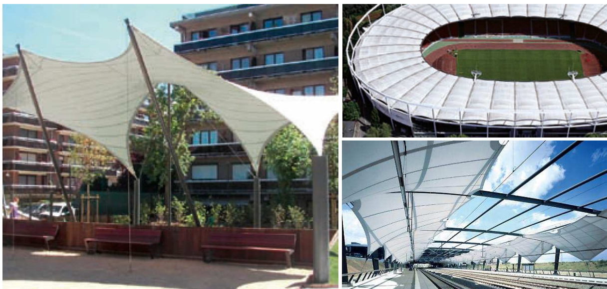
Slika 39: Primeri uporabe membran za izdelavo fleksibilnih nateznih membranskih konstrukcij.
