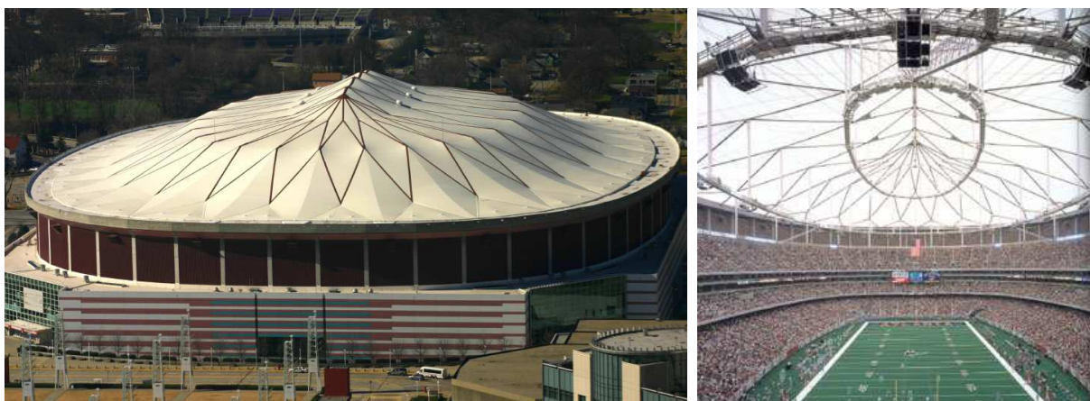
Slika 17: Stadion Georgia Dome v Atlanti, ZDA, zgrajen leta 1992, s kabelsko kupolo v obliki kristala.
