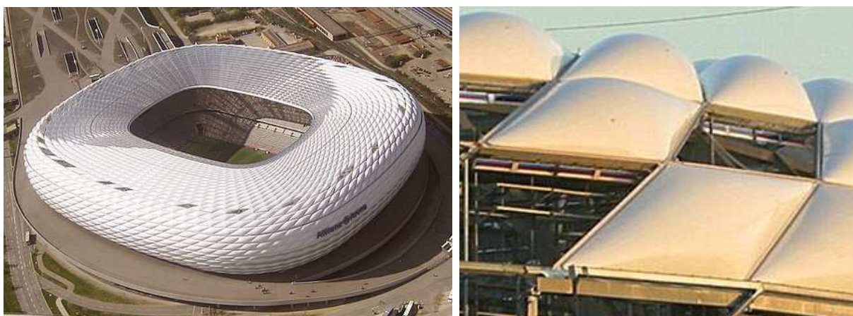
Slika 10: Natezna pnevmatska membranska konstrukcija Allianz Arene, München, Nemčija, iz napihljivih ETFE blazin.
