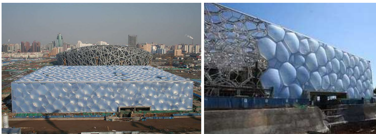
Slika 2: Olimpijski vodni center Beijing National Aquatics Centre, Peking, Kitajska s fasado in streho iz pnevmatske membranske konstrukcije iz ETFE folije.
