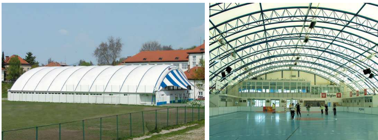
Slika 9: Natezna pnevmatska streha športnega centra Triglav v Ljubljani iz dvoslojne membrane, izdelane iz poliestrske tkanine prevlečene s PVC, ki je vgrajena med nosilno konstrukcijo iz paličnih lokov.
