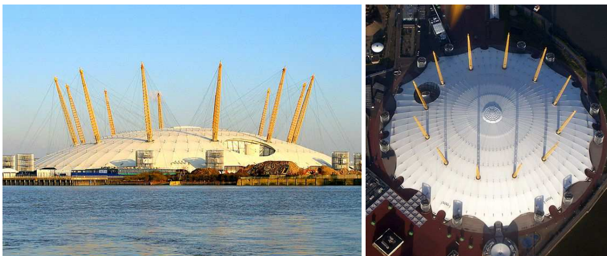
Slika 7: Natezna membranska konstrukcija O2 Arene, London, Velika Britanija, ki jo preko kablov nosijo tlačno in upogibno obremenjeni jekleni stebri.
