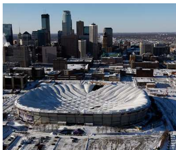
Slika 6: Pnevmatična streha nogometnega stadiona Metrodome, Minneapolis, Minnesota, ZDA pred porušitvijo decembra 2010 (levo) in po porušitvi (desno).
