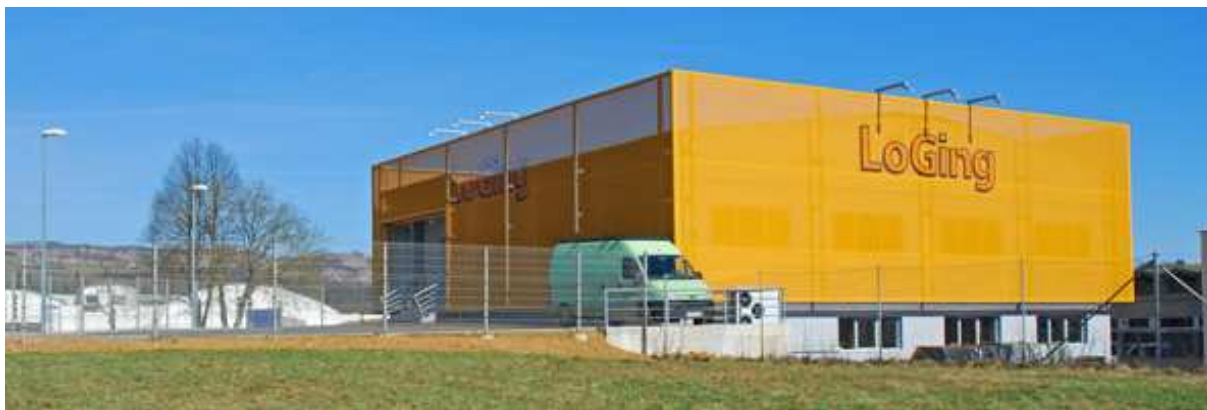
Slika 22: Prezračevana fasada iz mreže, oslojene s polimeri, na poslovno-proizvodnem objektu Loging v Novem mestu, ki zmanjšuje stroške klimatizacije za 30%.
