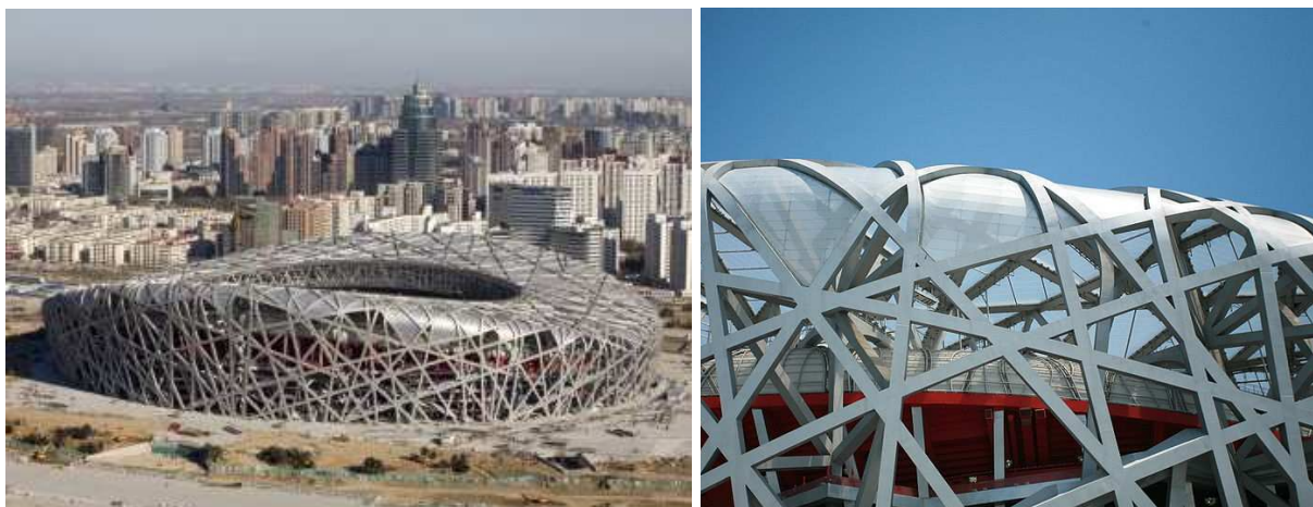
Slika 1: Olimpijski stadion Beijing National Stadium, Peking, Kitajska, s polnilom iz tkanine prevlečene s PTFE in ETFE folije med nosilnimi elementi strehe in fasade.
