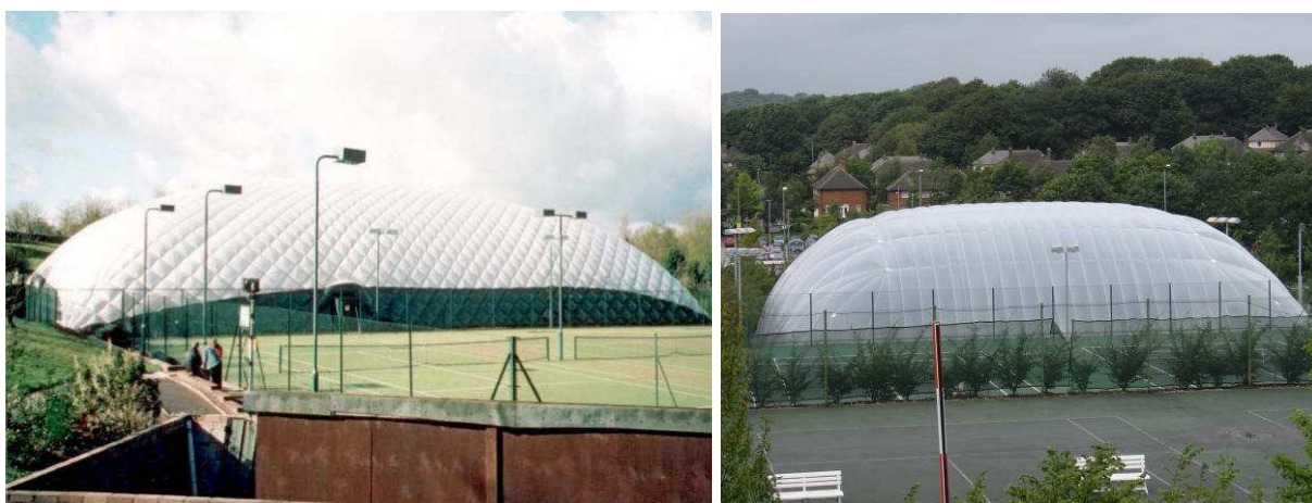
Slika 3: Zračno podprt pnevmatski objekt z ojačitveno mrežo kablov (levo) in prosojni pnevmatski objekt iz ojačane ETFE folije (desno).
