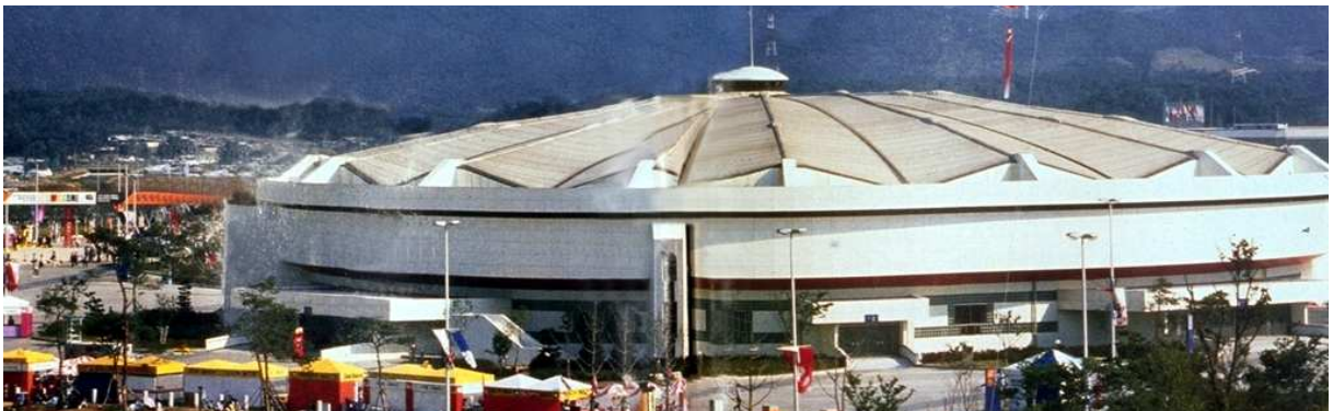
Slika 13: Kabelska streha gimnastične olimpijske arene v Seulu, Južna Koreja, postavljene za olimpijske igre leta 1988.
