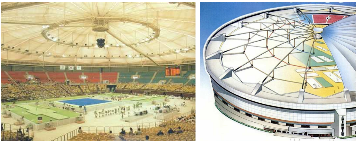
Slika 14: Notranjost gimnastične arene (levo) in konstrukcija njene kabelske kupole (desno).
