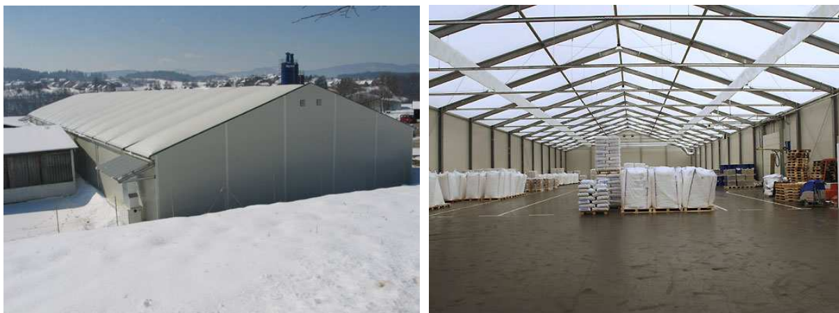
Slika 52: Skladišče farmacevtskih izdelkov tovarne zdravil Krka d.d. v Novem mestu s streho iz dvoslojnih ponjav, ki pri tleh objekta pri dnevni svetlobi zagotavljajo osvetljenost 200 lux, kar zadošča za branje oznak na skladiščnem blagu brez potrebne dodatne osvetlitve.
