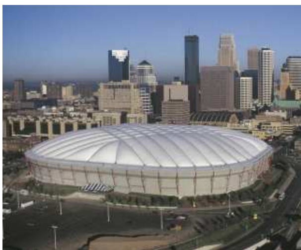
Slika 6: Pnevmatična streha nogometnega stadiona Metrodome, Minneapolis, Minnesota, ZDA pred porušitvijo decembra 2010 (levo) in po porušitvi (desno).
