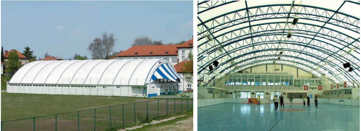
Slika 50: Dvorana športnega centra Triglav v Ljubljani s streho iz dvoslojnih svetlobo prepustnih pnevmatskih ponjav, pritrjenih na jeklene nosilne loke iz prostorskega paličja, prečno povezane z distančniki.
