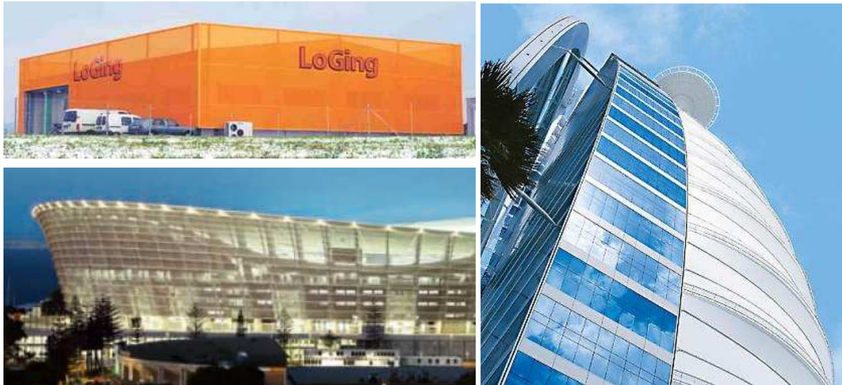
Slika 38: Primeri uporabe membran za izdelavo fasad.
