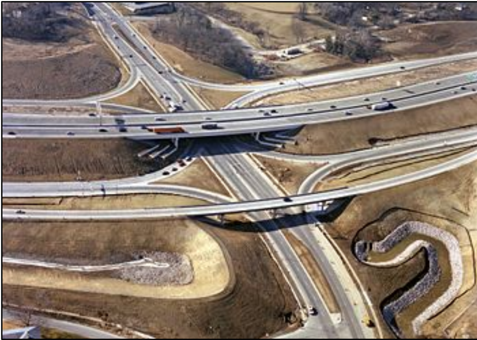
Slika 36: SPUI kakršen je bil izbran
