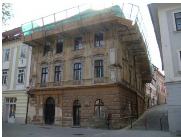
Slika 2.8: Obnova starega objekta v Ljubljani (Vir: Medmrežje 12)
