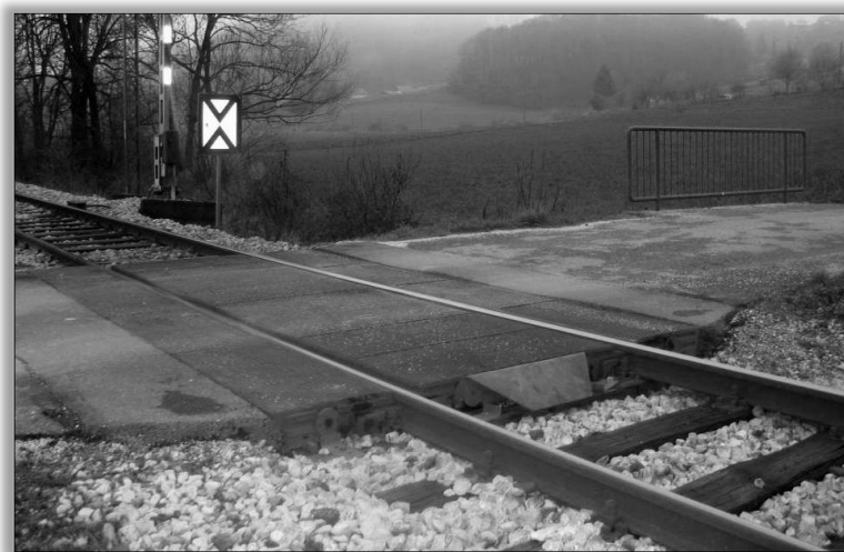
Slika 8: Nivojski prehod iz montažnih gumijastih elementov
