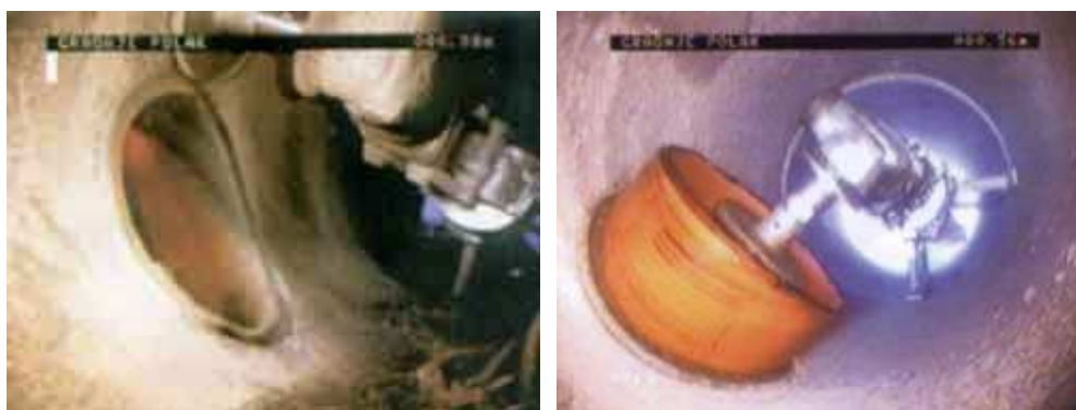
Privzeta slika13: Sanacija z robotom – Gradnje Polak
