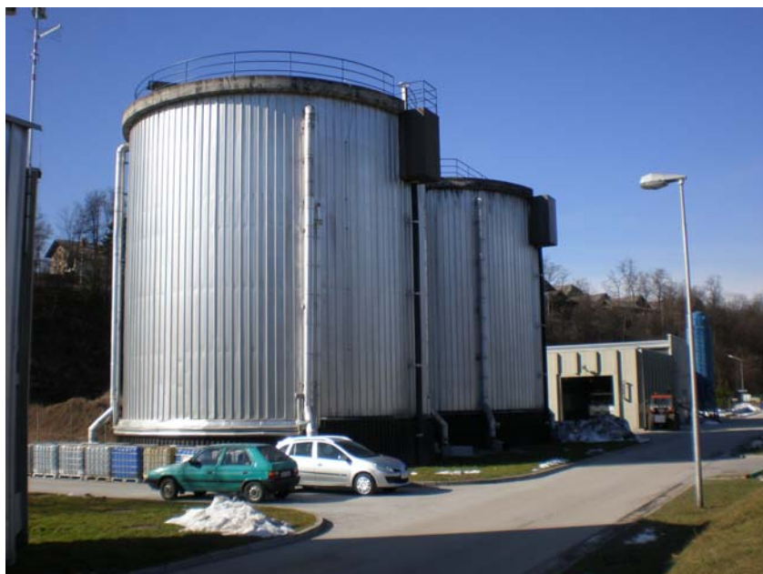
Slika 8: Primarno in sekundarno gnilišče (CČN Kranj, 12.2.2009)
