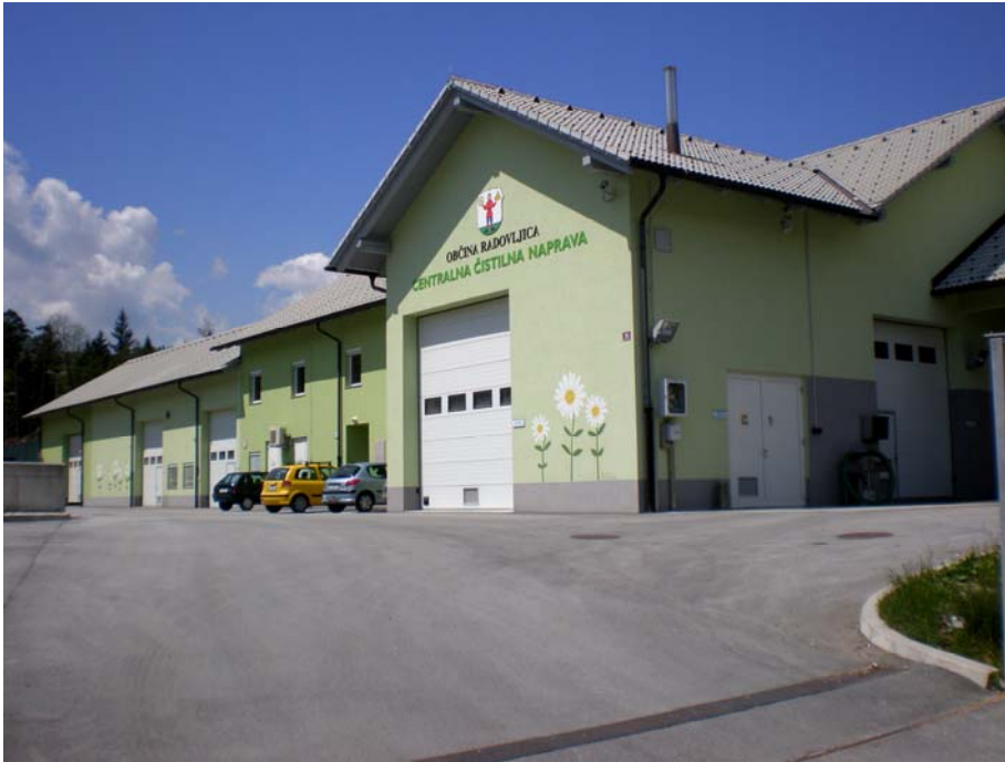
Slika 4: Centralna čistilna naprava Radovljica, zgrajena leta 2006 (8.5.2008)
