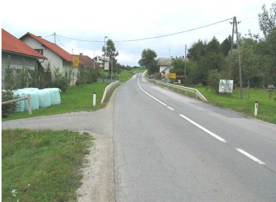
Slika 5.24 Pogled iz kraka A-Ivančna Gorica v smeri križišča oz. Pluske (prometno nevarni dovoz k kmetijskim poslojem; zaradi ugodnih horiz. in vertik. elementov velike hitrosti)
