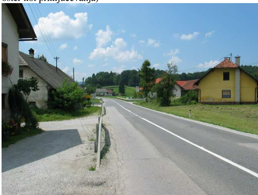
Slika 5.23 Pogled iz kraka C-Pluska v smeri križišča oz. Ivančne Gorice (prometno varnost zmanjšujejo dovozi v neposredni bližini križišča; zaradi obstoječih objektov in rastlinja je križišče slabo zaznavno)
