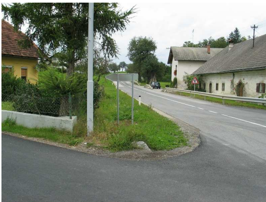
Slika 5.22 Pogled iz kraka D-Šentvid v smeri kraka C-Pluska (preglednost omejuje rastlinje in oster kot priključevanja)
