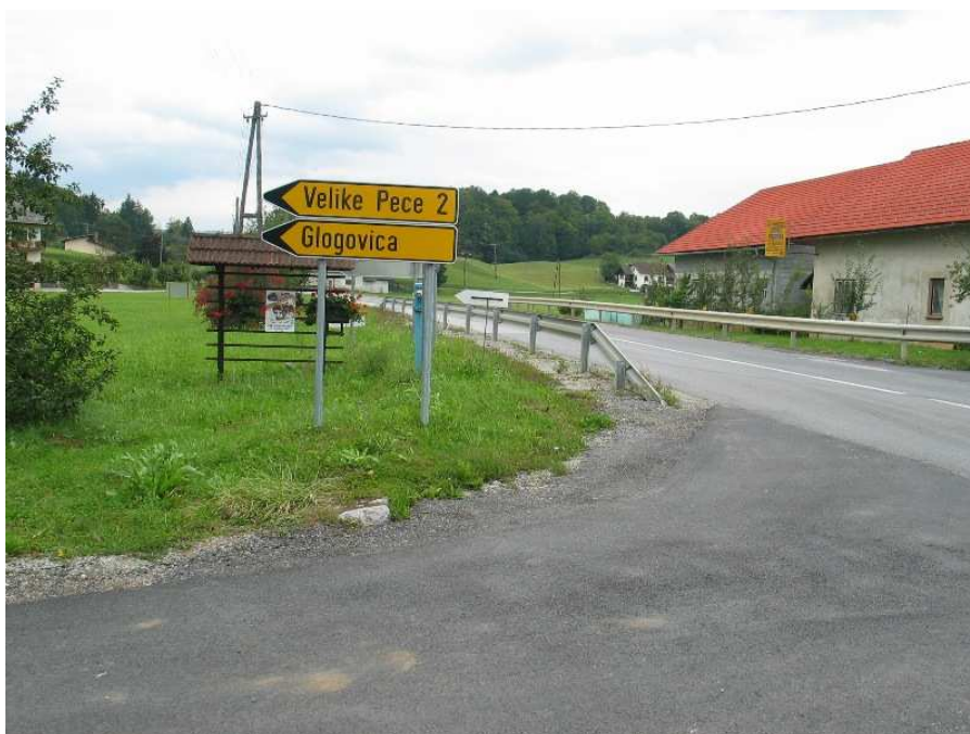
Slika 5.20 Pogled iz kraka B-Glogovica v smeri kraka A-Ivančna Gorica (preglednost zmanjšuje obstoječa prometna in neprometna signalizacija)
