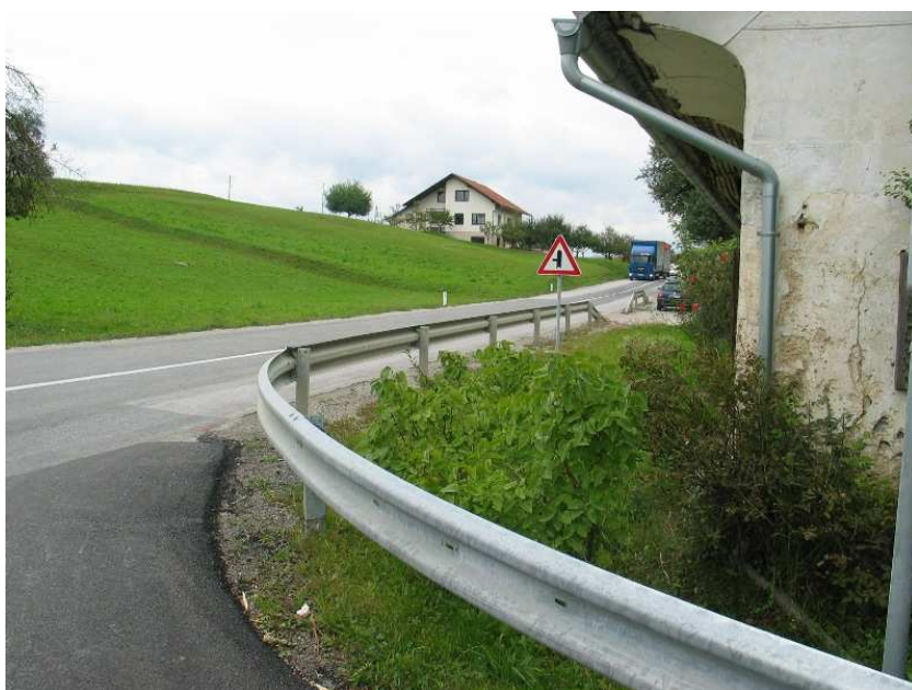
Slika 5.19 Pogled iz kraka B-Glogovica v smeri kraka C-Pluska (preglednost zmanjšuje obstoječa stanovanjska hiša)
