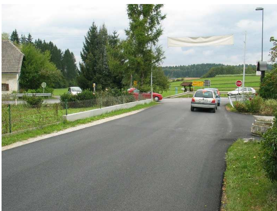
Slika 5.21 Pogled iz kraka D-Šentvid v smeri križišča (opazen je oster kot priključevanja, ki ovira preglednost pri vključevanju na regionalno cesto; zaradi zamika osi zahteva vključevanje v križišče veliko pozornosti, previdnosti in potrpežljivosti)
