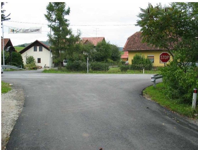
Slika 5.18 Pogled proti križišču iz lokalne ceste in smeri kraka B-Glogovica (viden je očiten zamik osi glede na krak iz smeri D-Šentvid)
