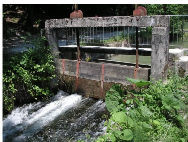
Slika 5: Preliv Homškega jez z zapornico za talni izpust na sredini v času nizkih vodostajev dne 21. 8. 2009, (levo) in zapornica, ki regulira količino odvzete vode za mlinščico (desno) (foto: Bogataj, 2009)
