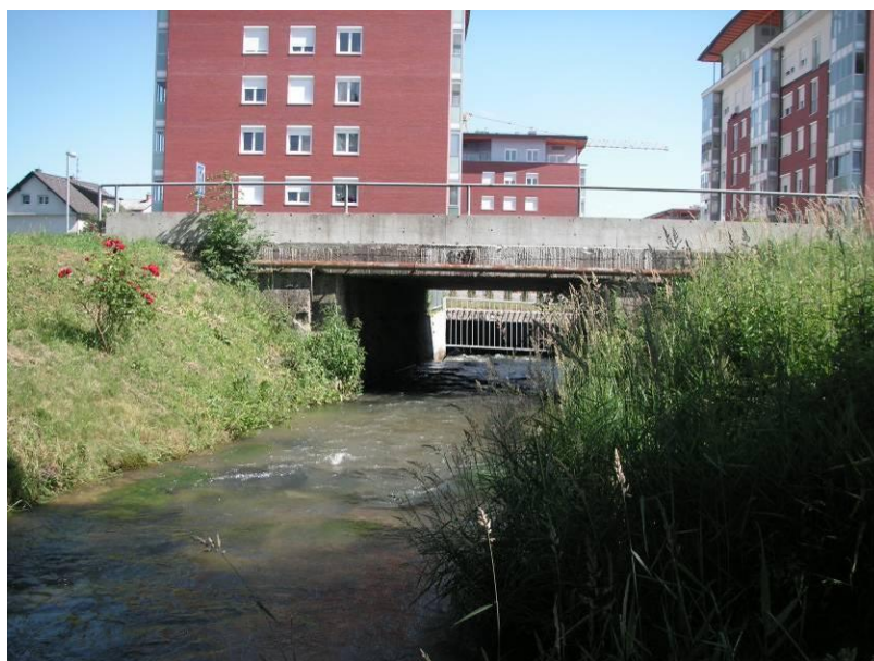
Slika 8: Vtok Homške mlinščice v pokrit kanal pod delom Domžal (foto: Bogataj, 13. 6. 2009)
