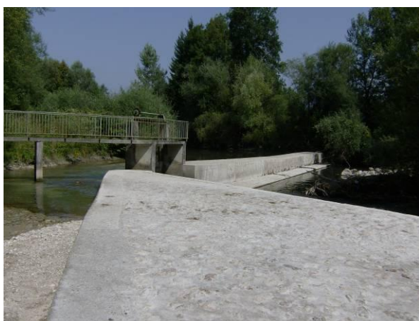
Slika 5: Preliv Homškega jez z zapornico za talni izpust na sredini v času nizkih vodostajev dne 21. 8. 2009, (levo) in zapornica, ki regulira količino odvzete vode za mlinščico (desno) (foto: Bogataj, 2009)
