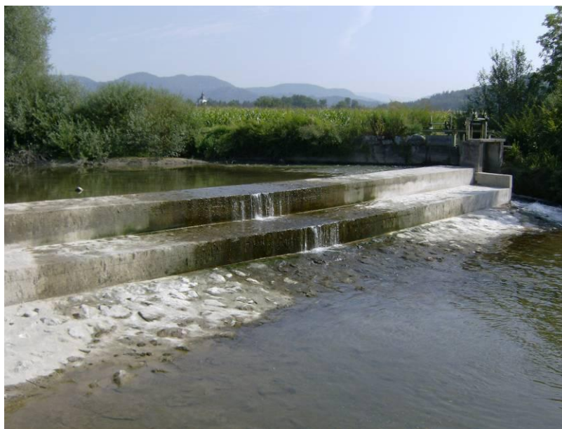
Slika 4: Radomeljki jez z levoobrežnim odvzemom z zapornicami in talnim izpustom v času nizkega vodostaja (foto: Bogataj, 28. 8. 2009)
