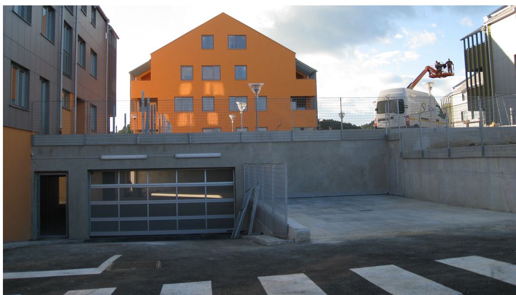
Slika 15: Vhod v garaže z Režunove ulice (gradnja, september 2007)
