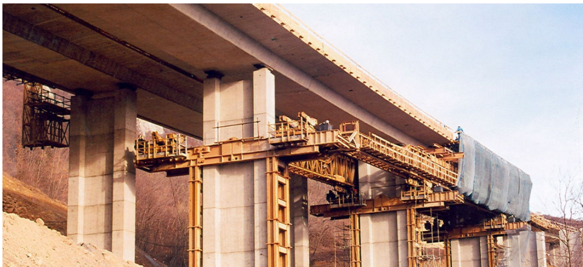
Slika 22: Gradnja viadukta Šumljak s tehnologijo pomičnega opažnega sistema (izvajalec Primorje) (Pržulj, 2004)
