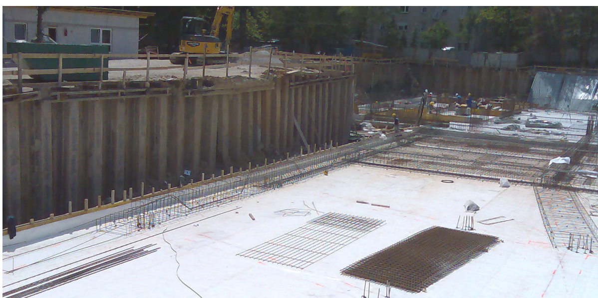
Slika 7: Gradbena jama, Center starejših občanov Trnovo, maj 2008
