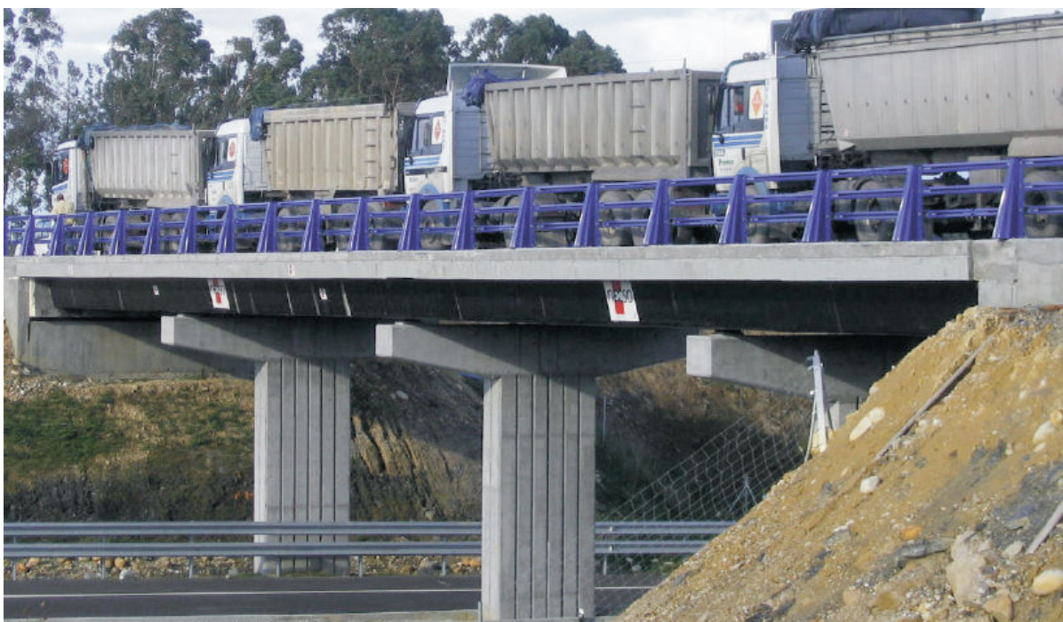
Slika 27: Most PUMACOM, Asturia, Španija, nosilno ogrodje je z ogljikovimi vlakni ojačana plastika (FPR)
