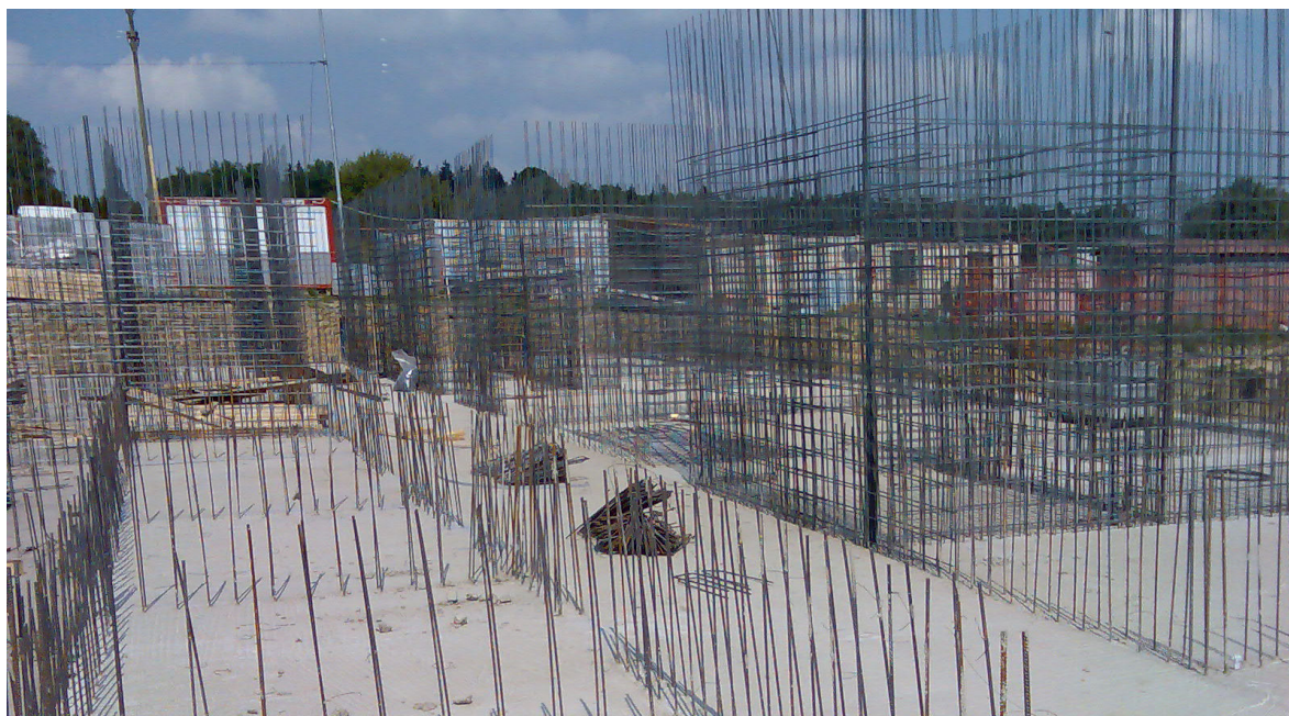
Slika 24: Armatura za armirano-betonske stene v kleti večstanovanjske stavbe
