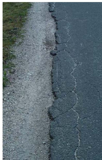
Krušenje roba (Redno vzdrževanje cest..., 2003: str. 25)
