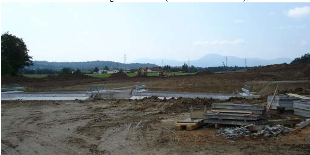
Slika 3-16: Trasa – začetek gradbenih del (odstranitev humusa), 1.6.2005
