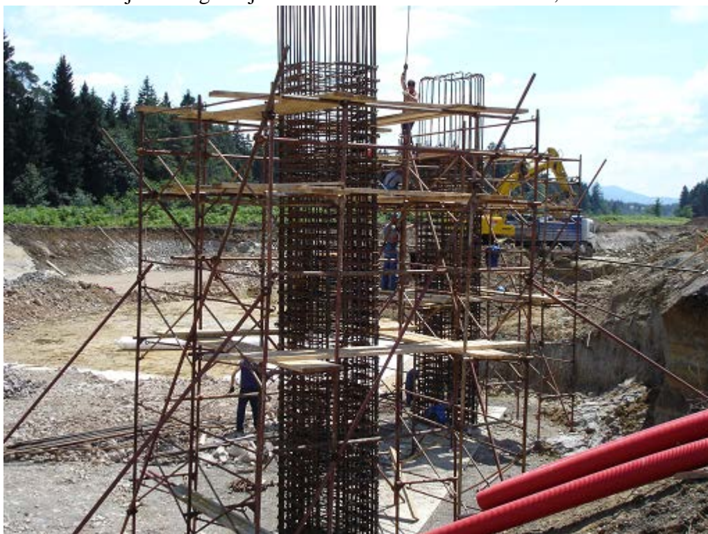
Slika 3-6: Objekti – vgradnja armature za stebre Nadvoza 4-4, 13.7.2005
