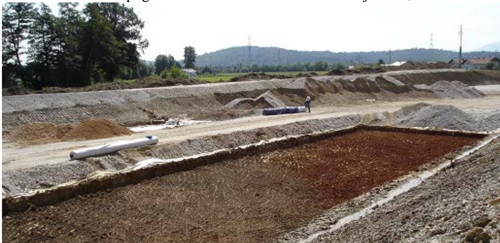
Slika 3-21: Trasa – poglobitve zaradi slabo nosilnih temeljnih tal, 25.8.2005
