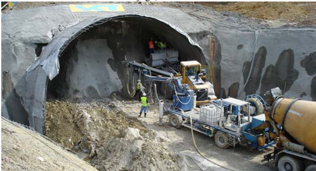
Slika 3-2: Predor – začetek del na jugu, 14.6.2005
