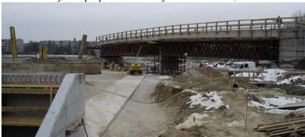
Slika 3-10: Objekti – podporna konstrukcija za Nadvoz 4-2A, 12.12.2005
