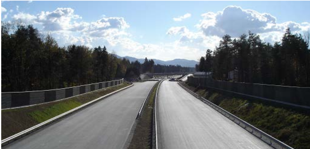
Slika 3-25: Trasa – začasno zaključena dela na trasi (P160 – P190), 10.11.2006
