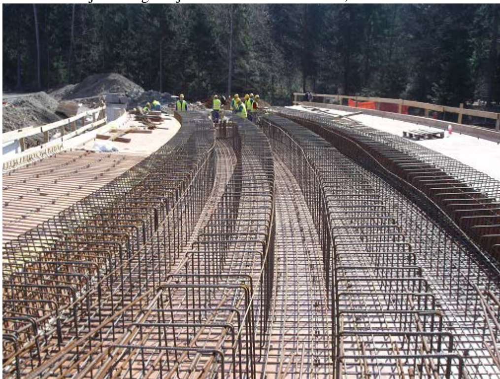
Slika 3-7: Objekti – vgradnja armature za Nadvoz 4-5, 13.4.2006
