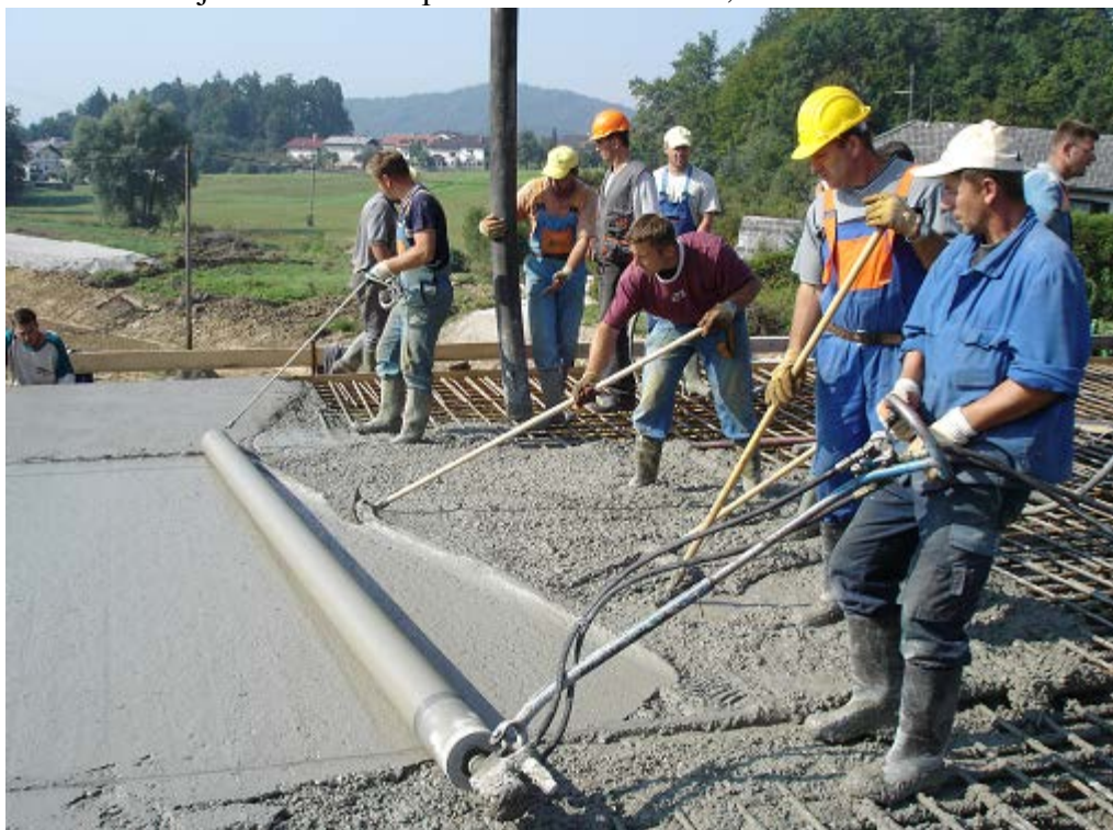
Slika 3-8: Objekti – izdelava plošče za Nadvoz 4-2, 7.9.2005
