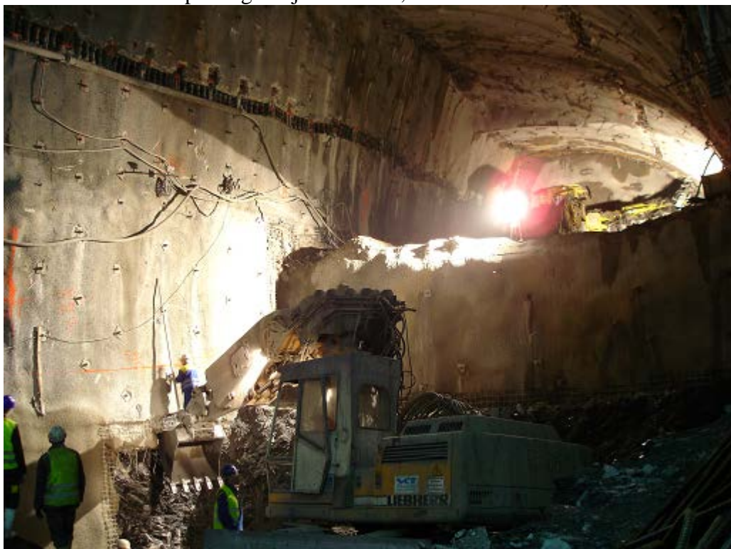
Slika 3-3: Predor – potek gradnje v kaverni, 24.3.2006
