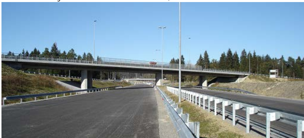
Slika 3-14: Objekti – dokončan Nadvoz 4-4, 10.11.2006
