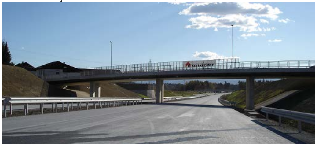
Slika 3-12: Objekti – dokončan Nadvoz 4-2, 10.11.2006
