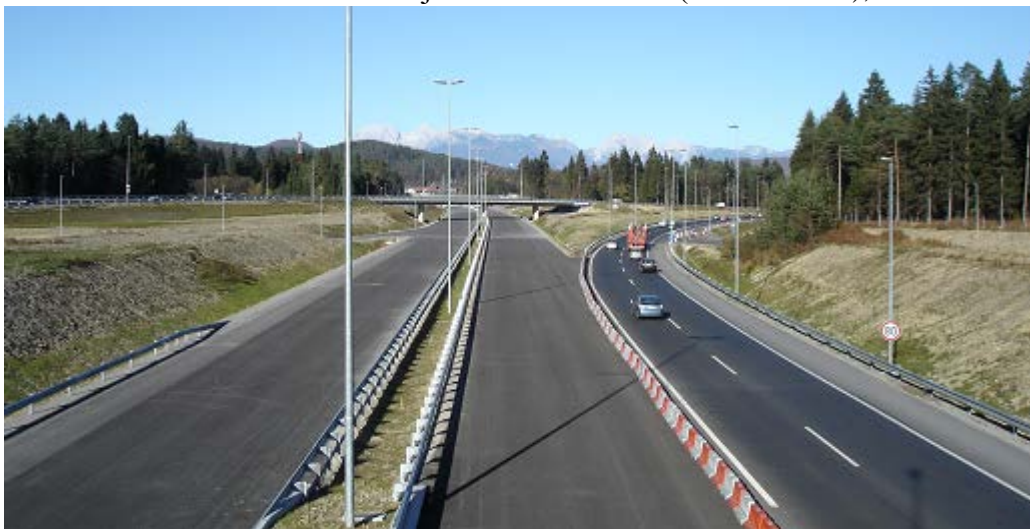
Slika 3-26: Trasa – začasno zaključena dela na trasi (P200 – P230), 10.11.2006
