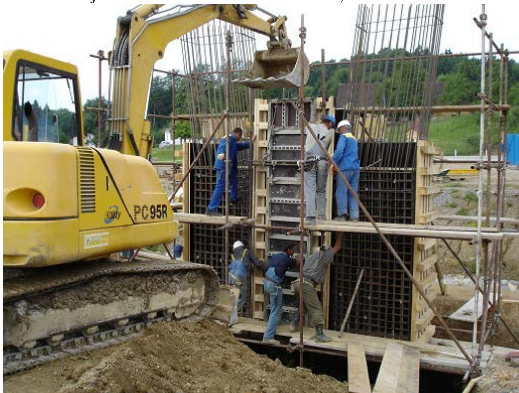
Slika 3-5: Objekti – izdelava stebrov za Nadvoz 4-1, 1.6.2005
