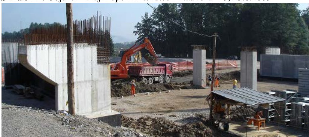
Slika 3-11: Objekti – krajni opornik ter stebri Nadvoza 4-3, 25.8.2005
