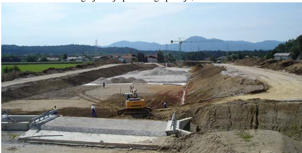
Slika 3-17: Trasa – vgrajevanje povoznega platoja, 10.8.2005
