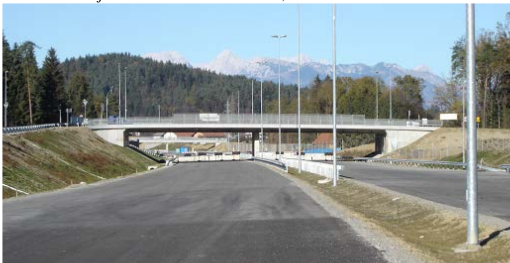
Slika 3-13: Objekti – dokončan Nadvoz 4-3, 10.11.2006
