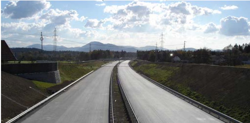
Slika 3-24: Trasa – začasno zaključena dela na trasi (P140 – P170), 10.11.2006
