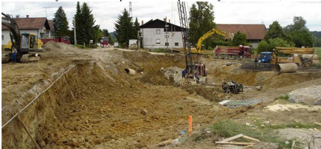
Slika 3-9: Objekti – izdelava pilotov in izkop za temelje Nadvoza 4-2, 8.6.2005
