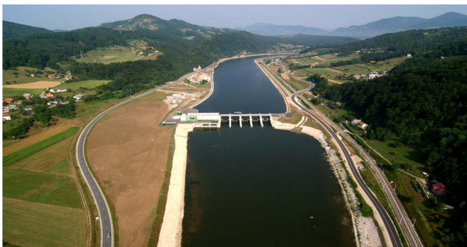
Slika 19 : HE Boštanj ( http://ocs-v3.ibe.si/pls/portal/docs/1/66224.JPG ).
