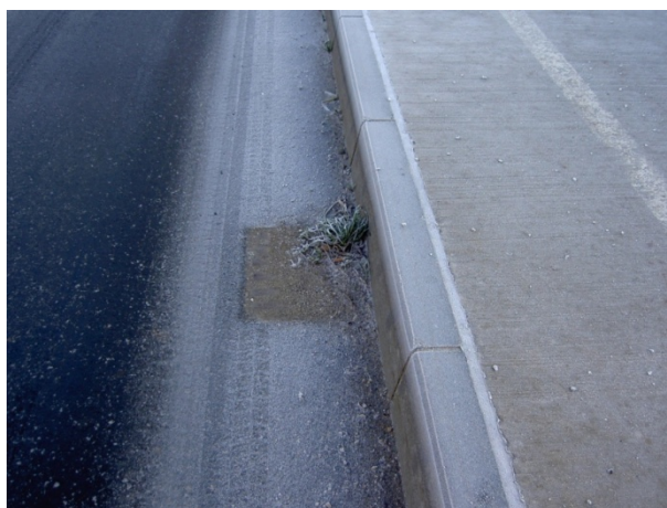
Slika 17: Zamašen vtočni del izlivnika
