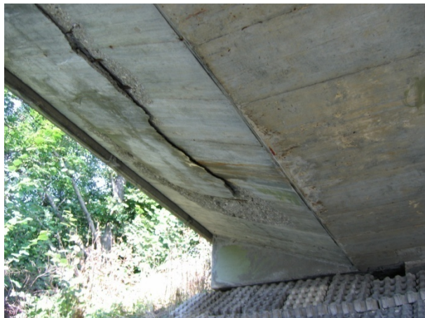
Slika 11: Razpadanje glavnega nosilca
