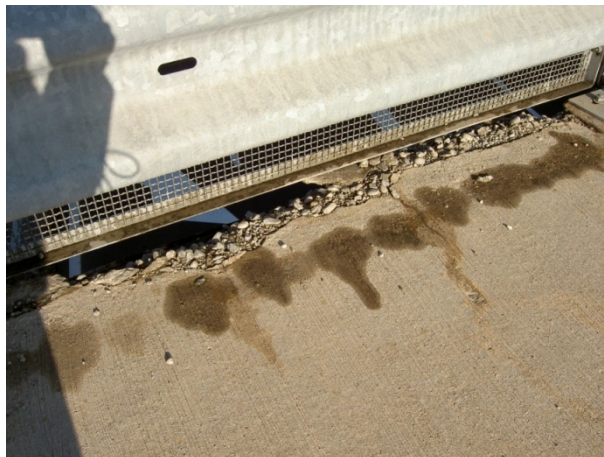
Slika 15: Razpadanje robnega venca zaradi zunanjih vplivov
