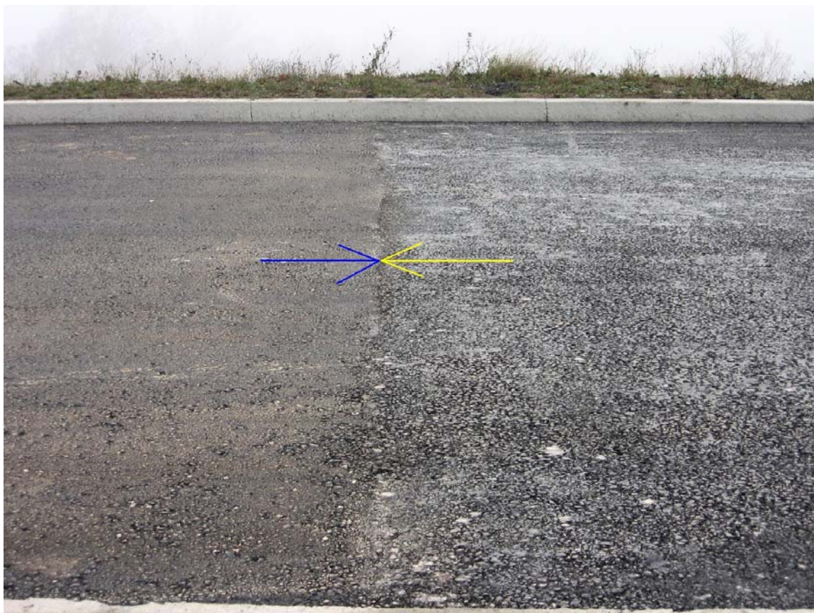
Slika 24: Uporaba dveh različnih bituminiziranih zmesi
