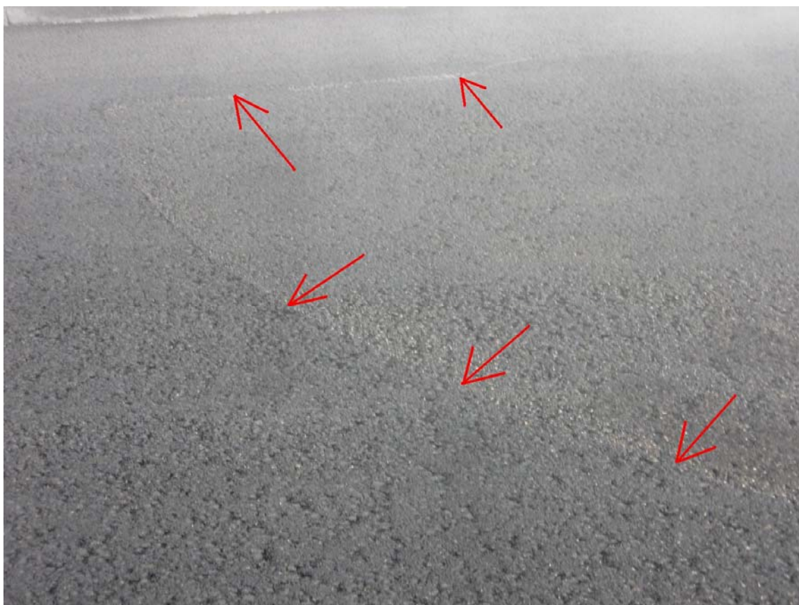
Slika 21: Neravnine, ki so nastale zaradi ustavljanja valjarjev
