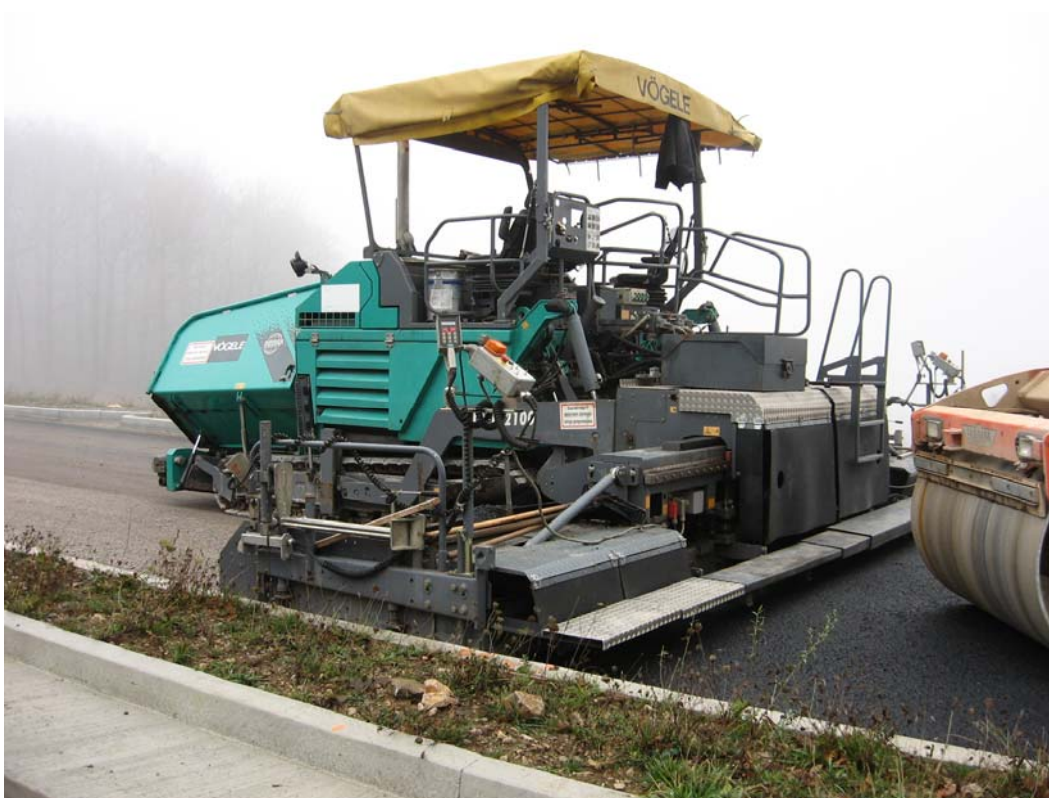
Slika 17: Prekinitvev dela finišerja
