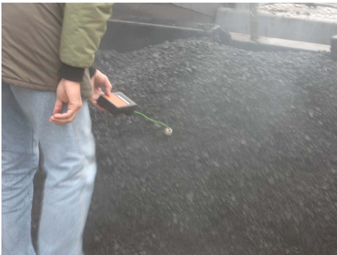
Slika 18: Meritve temperature bituminizirane zmesi pri vgradnji
