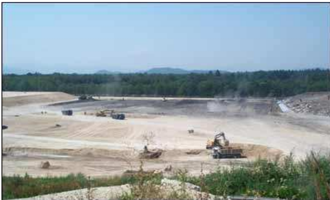
Slika 2.6: Odlagalna polja novega dela odlagališča komunalnih odpadkov Barje (Snaga, 2005)
