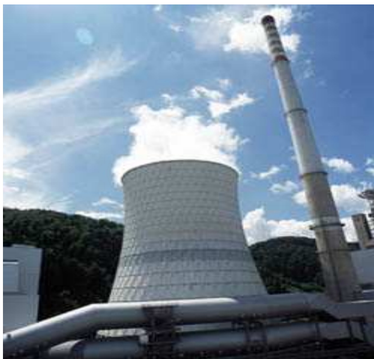
Slika 2.2: Onesnaževanje zraka iz industrije – dimnik termoelektrarne Šoštanj ( http://www.te-sostanj.si , 09. 12. 2005)
