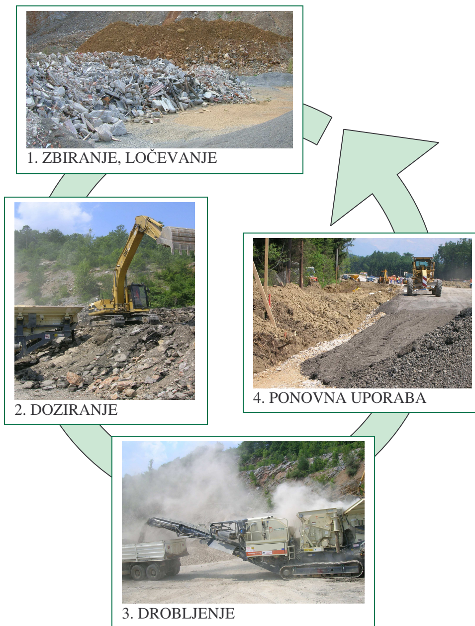
Slika 5.5: Postopek predelave gradbenih odpadkov – osnovne operacije
