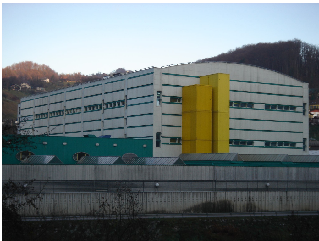
Slika 2: Polnilnica v Laškem – zahodna in severna fasada
