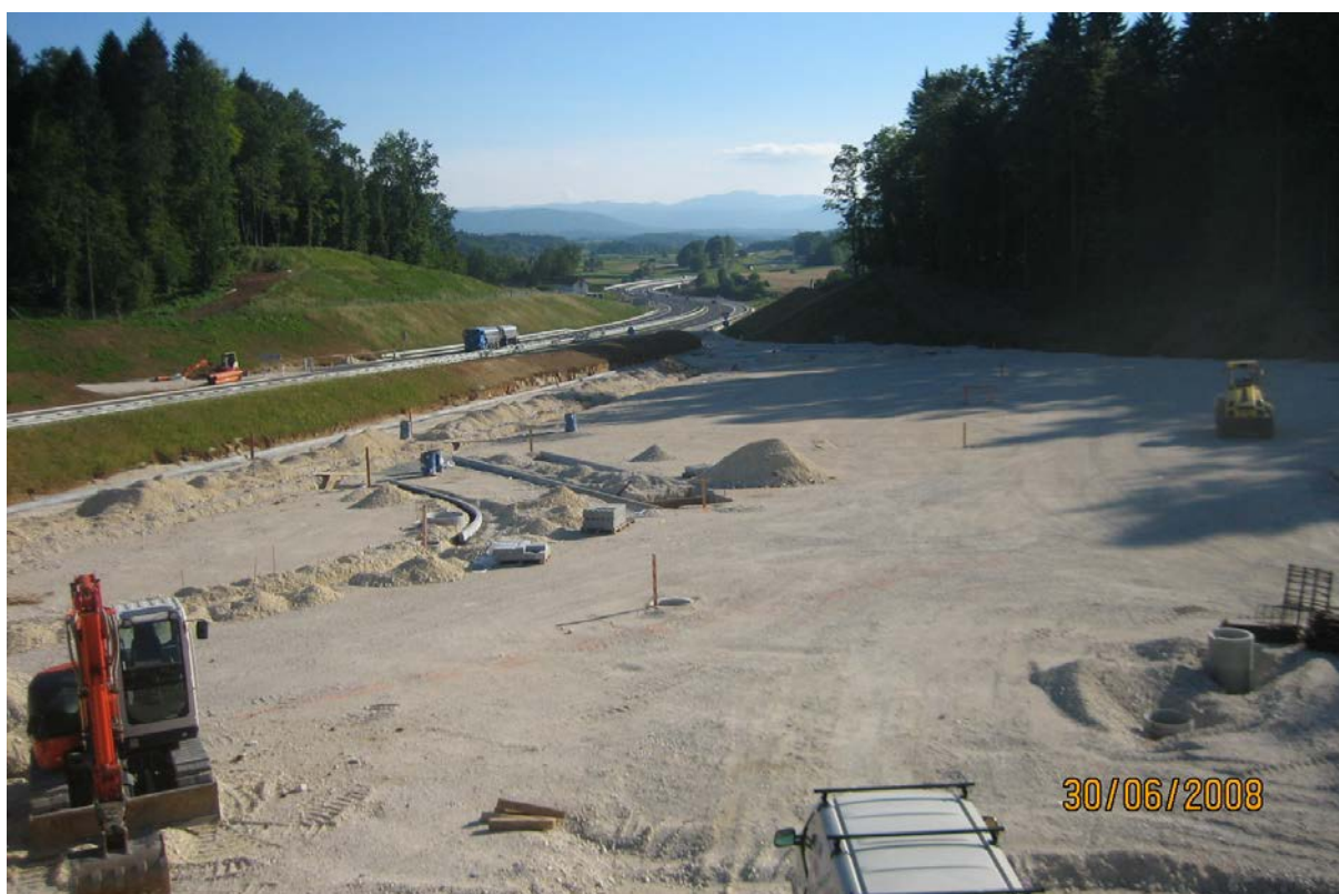
Slika 13: Začetno stanje na gradbišču Oskrbnega platoja Starine Jug
