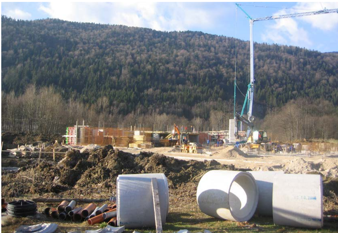
Slika 7: Začetek gradnje Športne dvorane Kočevje
