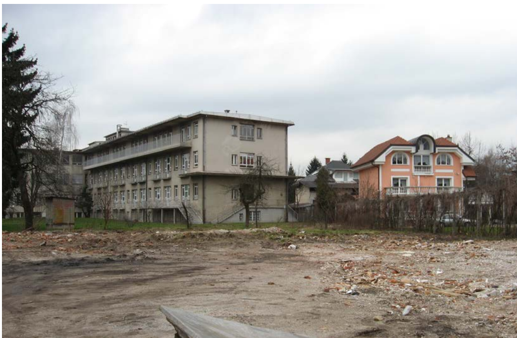
Slika 10: Začetno stanje na gradbišču objekta Bohoričeva
