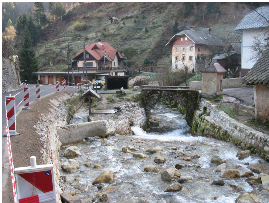
Slika 39: Pogled na vtok v rake na prelivu drče v profilu P10 in obokan most v profilu P9 (PUH, 2008)
