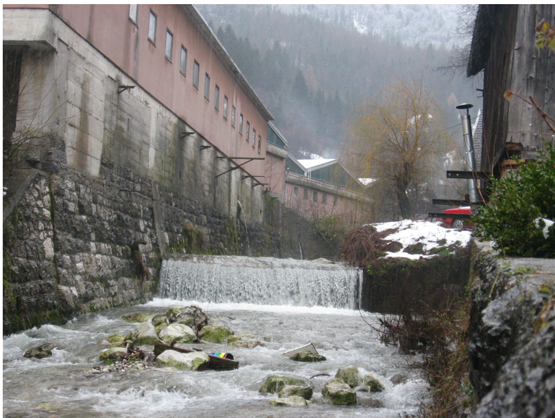
Slika 41: Betonski prag s stopnjo 1,30 m v območju profila 3A (PUH, 2008)
