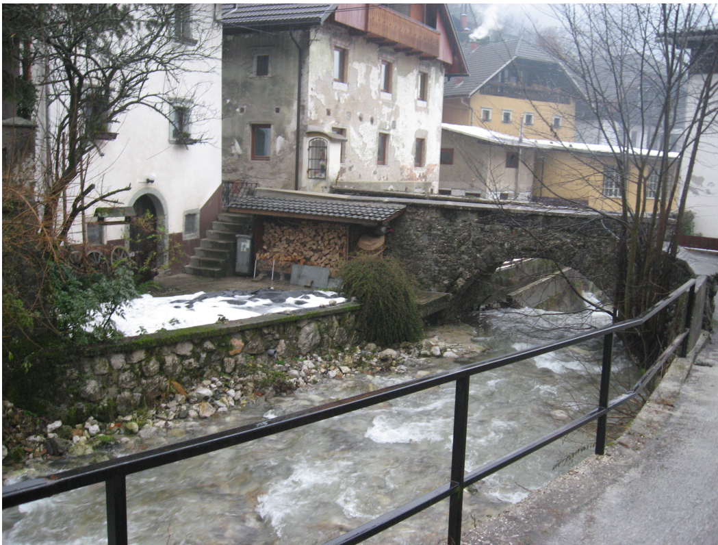
Slika 42: Vtok pod most v profilu P4 pri stanovanjski hiši Kropa 82 s prenizko urejenim vrtom in vhodom (PUH, 2008)
