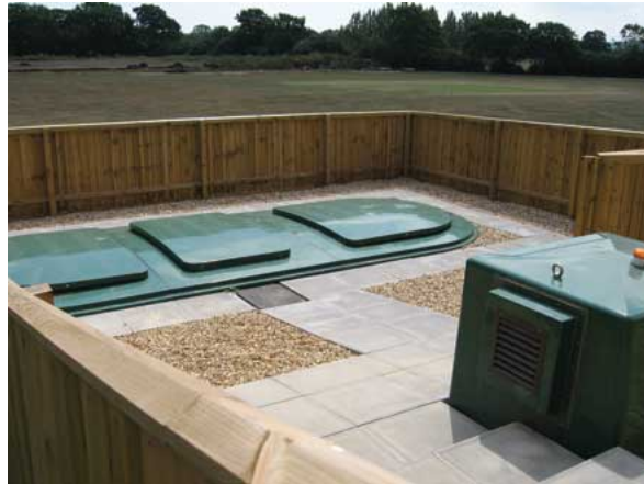
Slika 6.3: Primer srednje čistilne naprave HiPAF in kioska ( http://www.wpl.co.uk )
