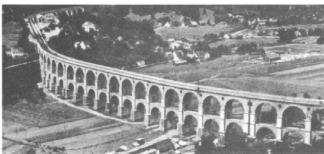
Slika 14: Borovniški viadukt (Bogić, 1989. Str. 9).
