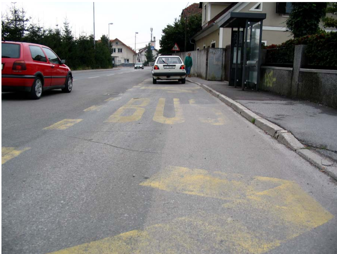
Slika 8 : Obraba asfalta na avtobusni postaji
