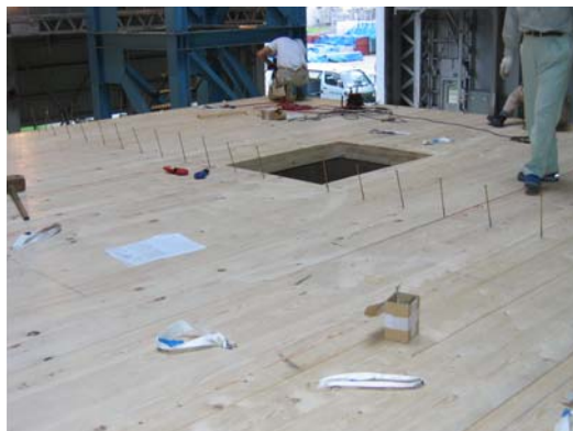
Slika 18: Skica in slika preklonih stikov med paneli medetažne plošče in povezave plošč s spodnjimi stenami
