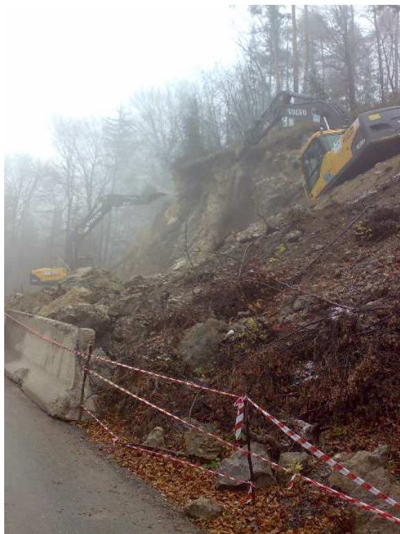
Slika 34: Pikiranje laporja in zaščita ceste z betonsko ograjo
