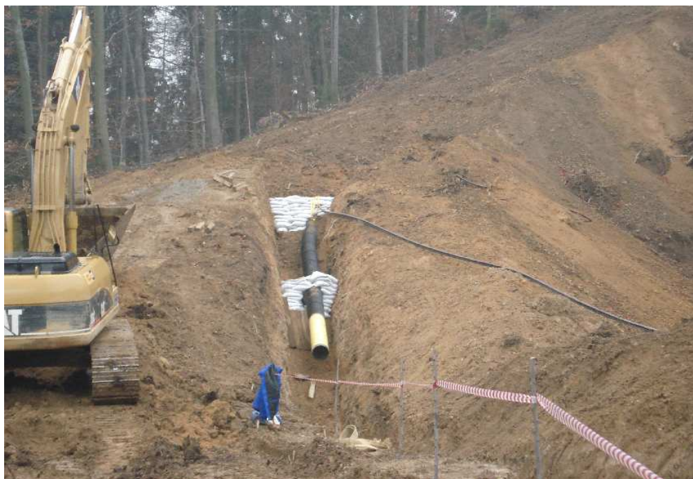
Slika 16: Polaganje cevi na območjih z velikimi nakloni: vreče
