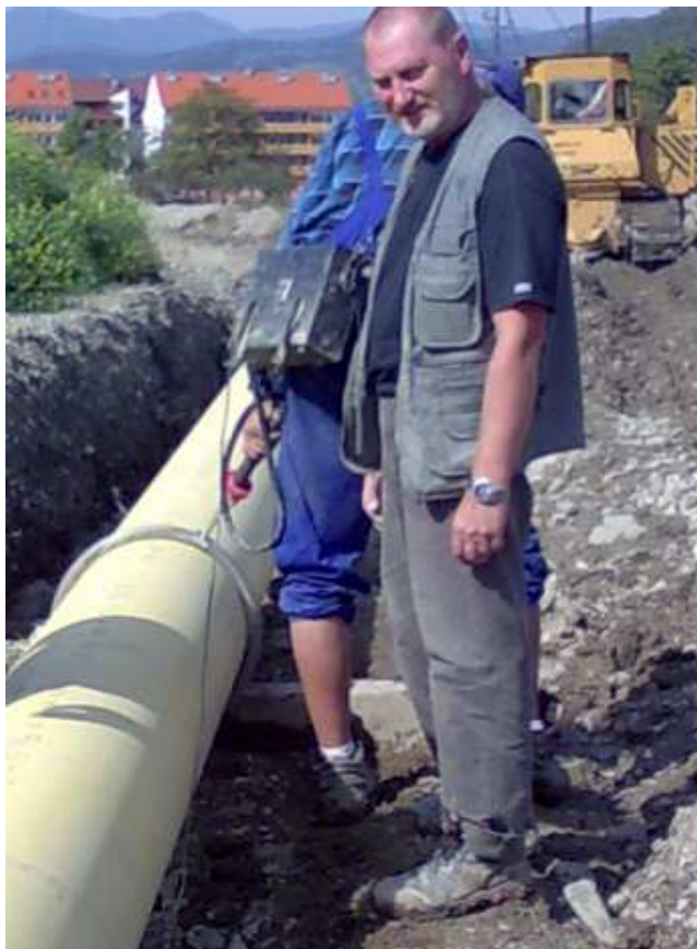
Slika 13: Kontrola izolacije
