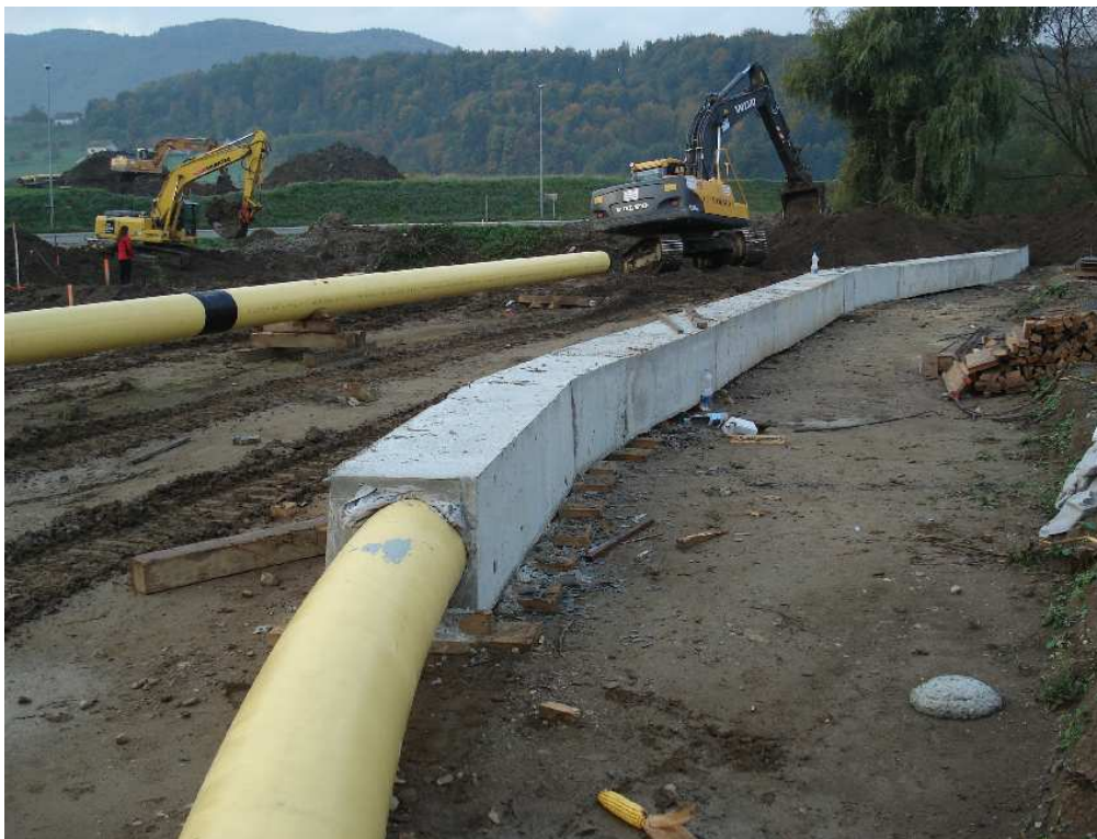
Slika 31: Obbetonirana cev za reko Pako V4
