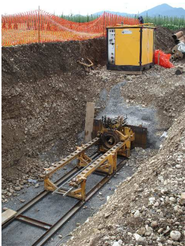
Slika 8: Gradbena jama za podvrtavanje
