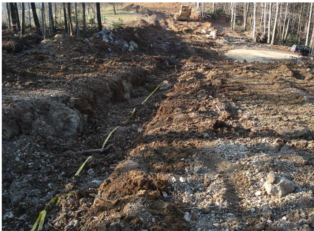
Slika 19: Opozorilni trak »POZOR PLINOVOD«
