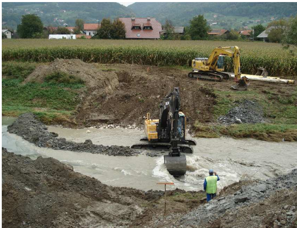
Slika 30: Prekop reke Pake V2
