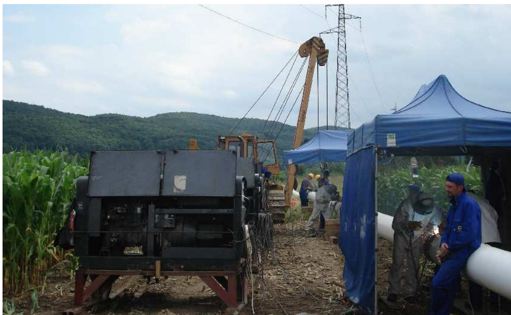
Slika 10: Varjenje linijskih zvarov
