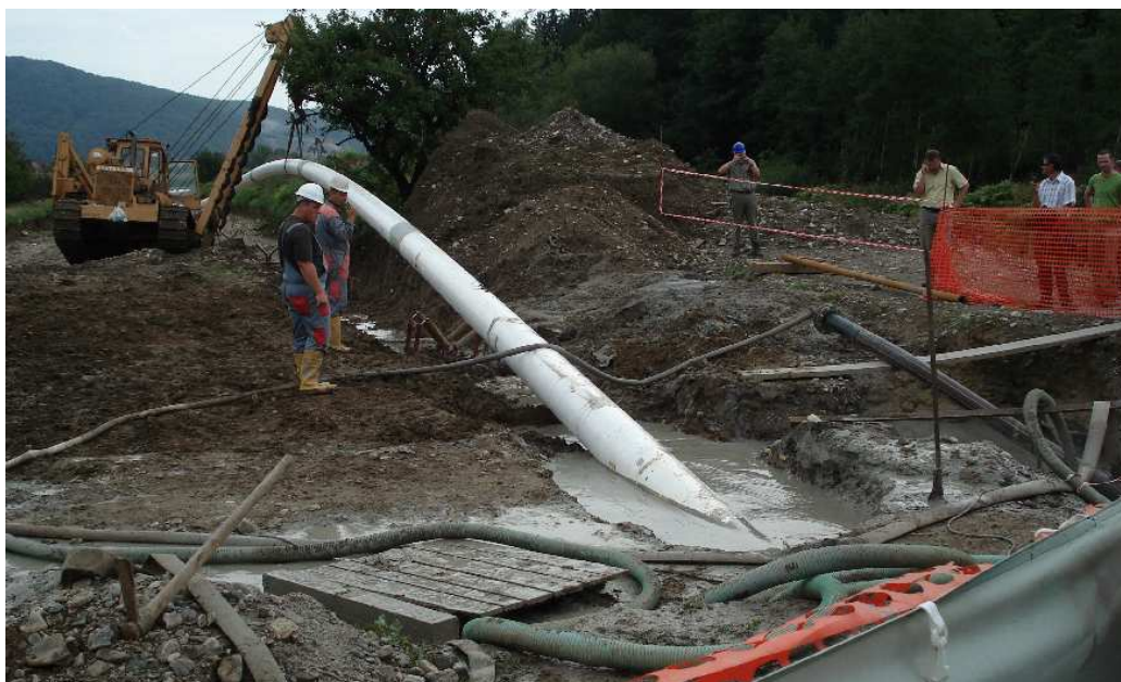
Slika 32: Uvlačenje cevi
