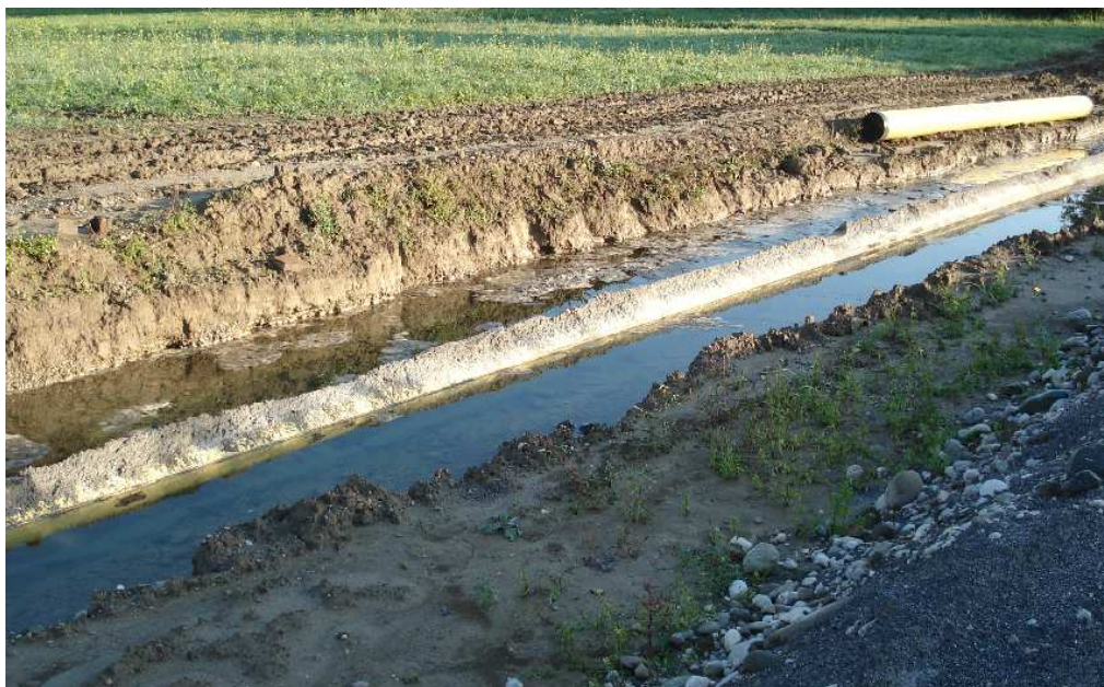
Slika 26: Napolnjen jarek z vodo in dvig cevi
