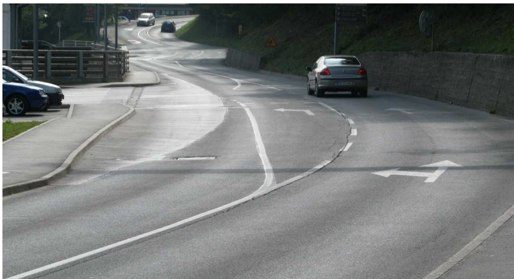
Slika 14: T križišče z naknadno izvedenim pasom za leve zavijalce
