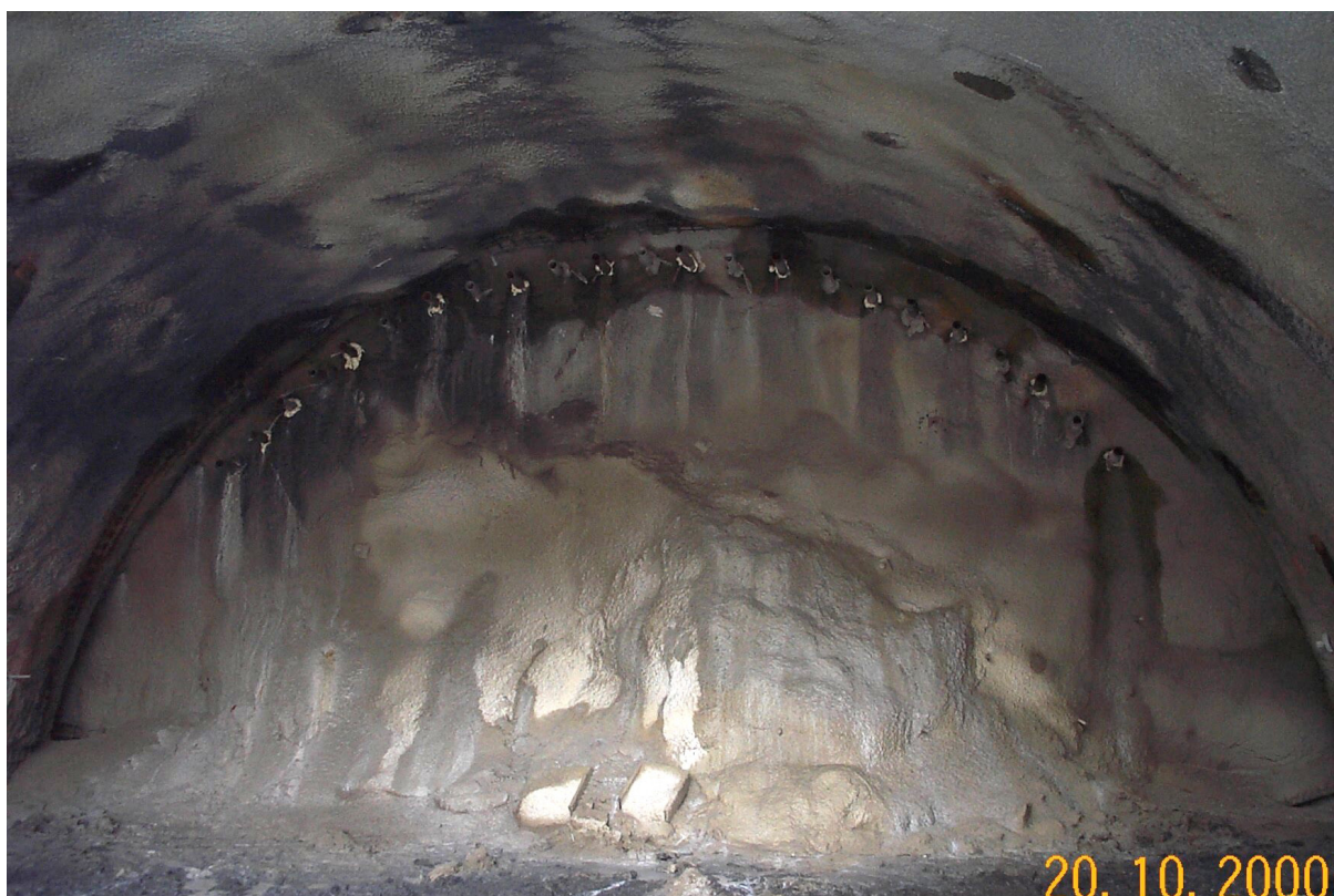
SLIKA 16: Prikaz cevnega ščita v predoru Trojane
