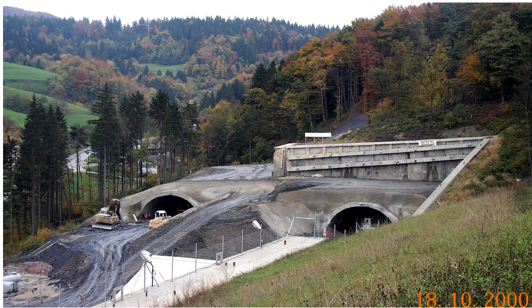
SLIKA 7: Zahodni portal v času gradnje
