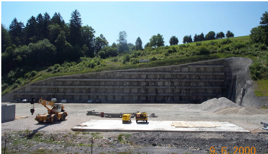
SLIKA 6: Vzhodni portal v času gradnje
