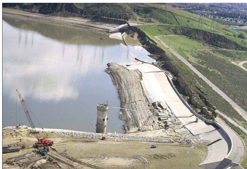
Slika 9: Porušitev pregrade v San Fernandu po potresu leta 1971 ( http://www.ce.washington.edu/~liquefaction/html/what/what1.html )
