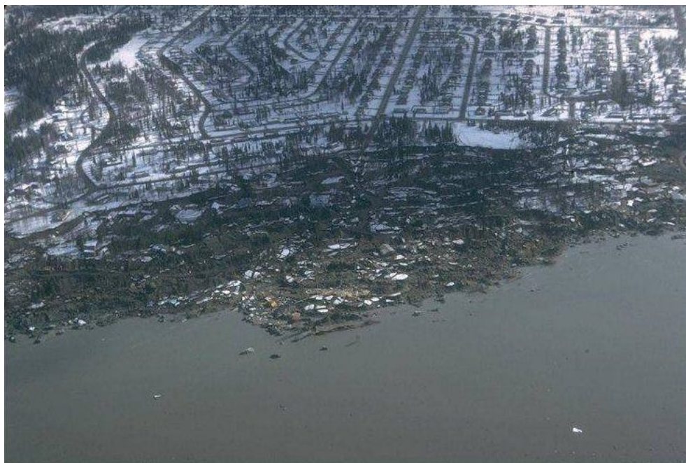
Slika 7: Posledice potresa na Aljaski (1964, magnituda 9,2 in trajanje približno 3 minute) ( http://en.wikipedia.org/wiki/1964_Alaska_earthquake )
