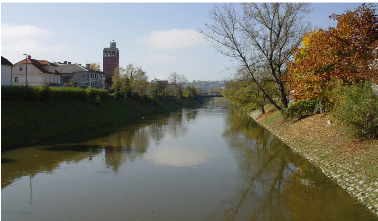
Slika 18: Regulirana struga reke Ljubljanice v Mostah je neprepustna in zablatena (foto: Savić, sep. 2008)
