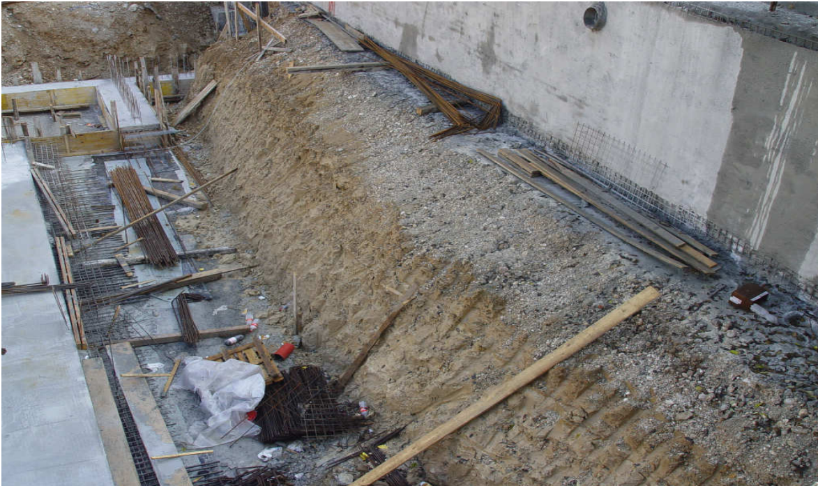
Slika 8: Plast gline na gradbišču ob občinski stavbi v Mostah (foto: Savić,2008)
