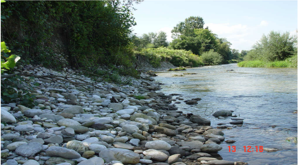
Slika 17: Posledice bočne erozije v strugi reke Save, koristna za povečanje infiltracijske površine (Foto: Savić sep.08).
