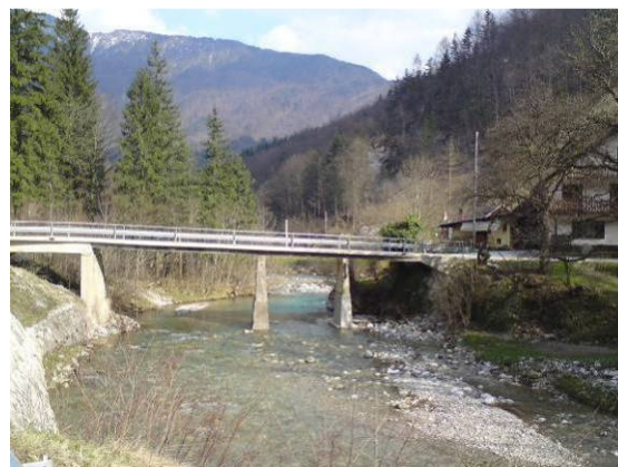
Slika 18: Predvidena lokacija strojnice, pogled proti Kokri gorvodno (Mrak, 2010)
