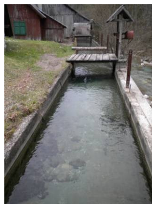
Slika 10: Dovodni kanal na mHE Virnik (Mrak, 2010)
