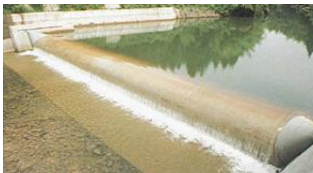
Slika 4: Primer izvedbe jezua z gumeno membrano (www.savatech.si)
