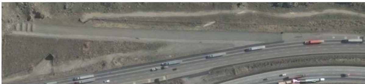
Slika 15: Gravitacijski zasilni izvoz s štirimi nasipi, Tejon Pass, I-5, ZDA (Google Earth).
