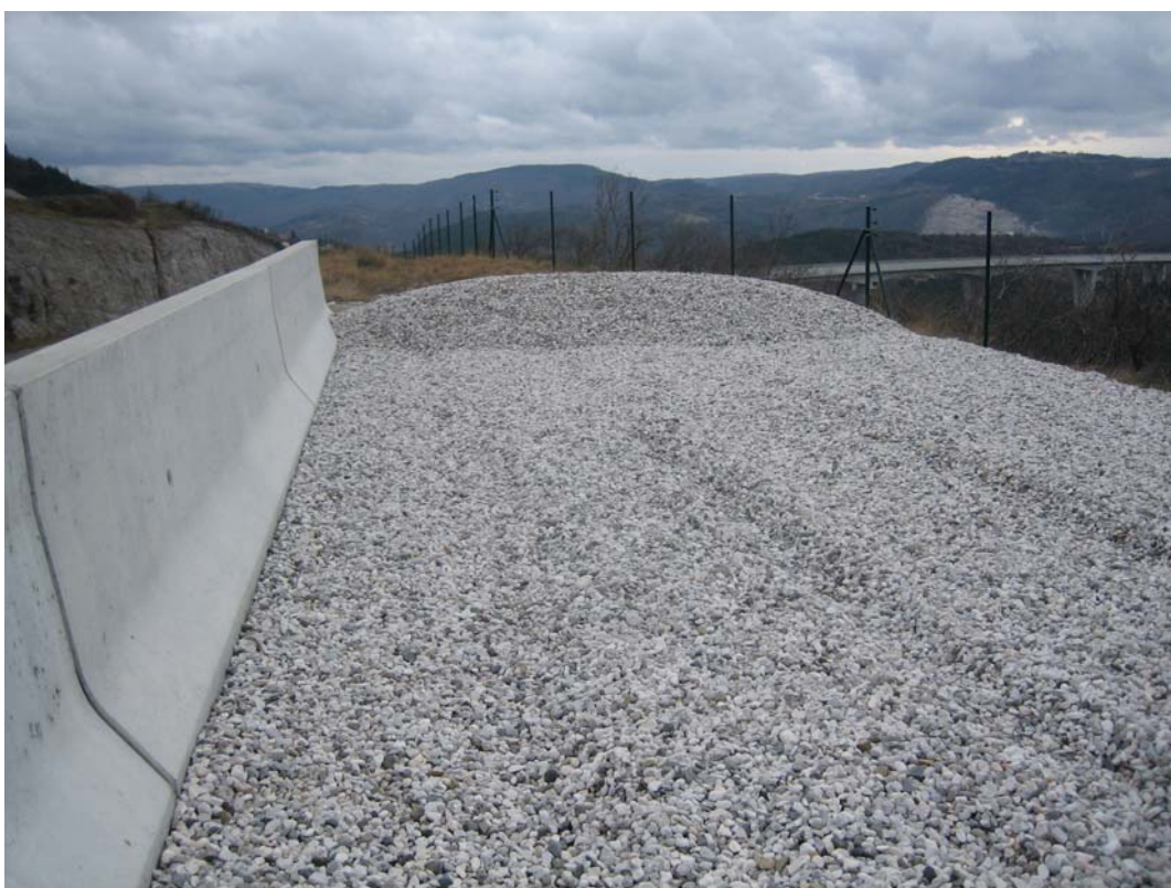
Slika 18: Betonska varnostna ograja za varovanje in preprečevanje raztrosa agregata na Črnem Kalu
