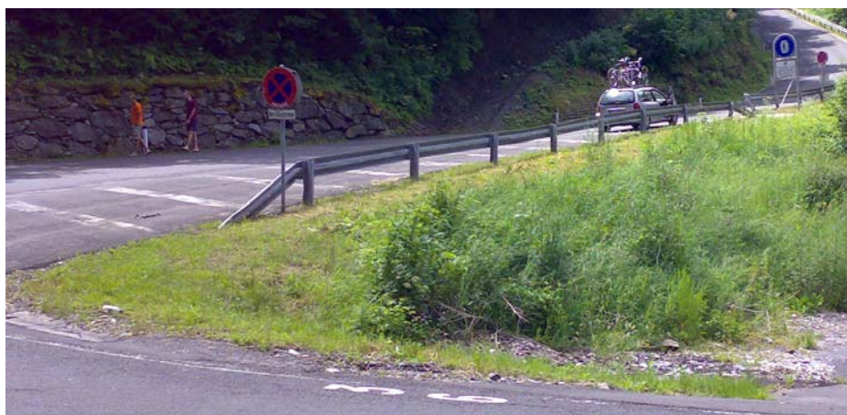
Slika 44: Razširitev vozišča rezerviranega za pobegla vozila s prometnim znakom za prepovedano ustavljanje in parkiranje
