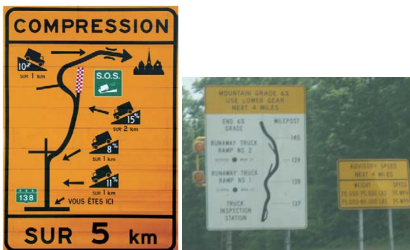
Slika 28: Prometne table za seznanjanje šoferjev tovornih vozil o poteku in nagibu trase
