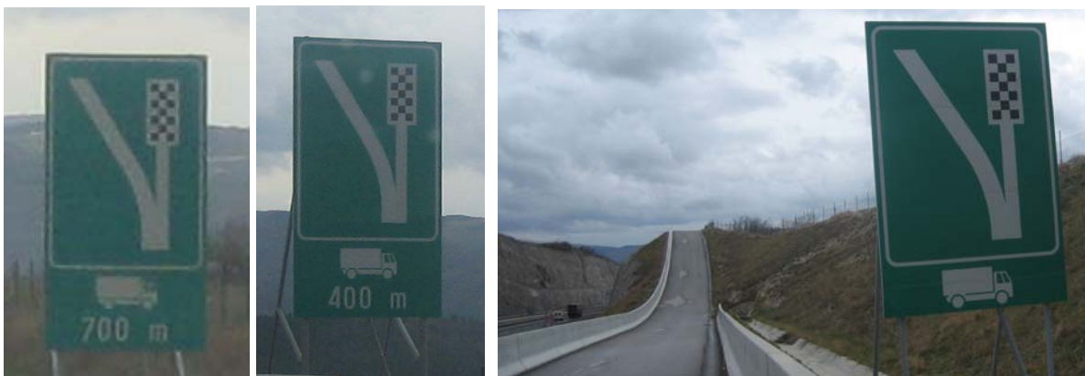
Slika 40: Zaporedje prometnih tabel za označevanje zasilnega izvoza na Črnem Kalu
