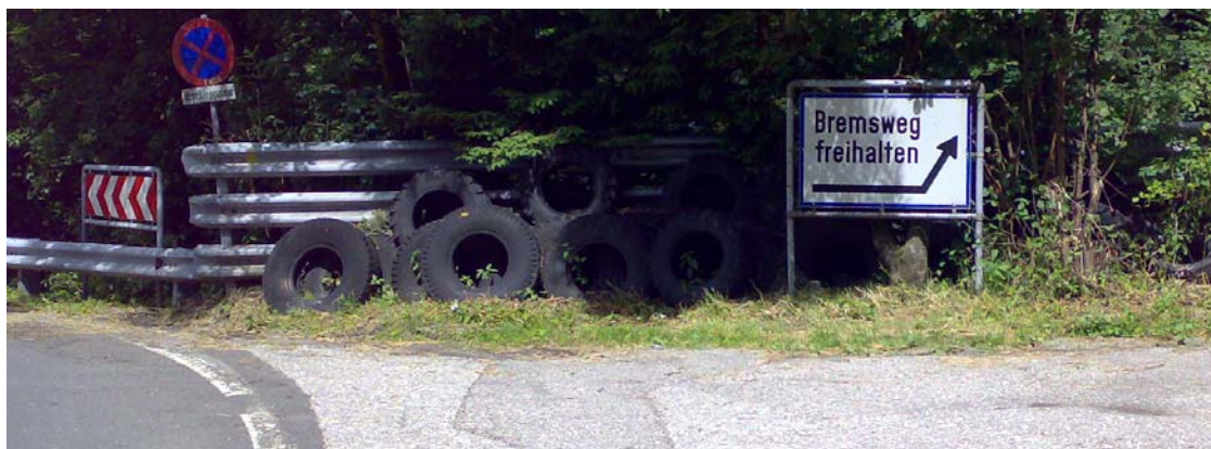
Slika 45: Blažilnik naleta iz pnevmatik in jeklene varnostne ograje
