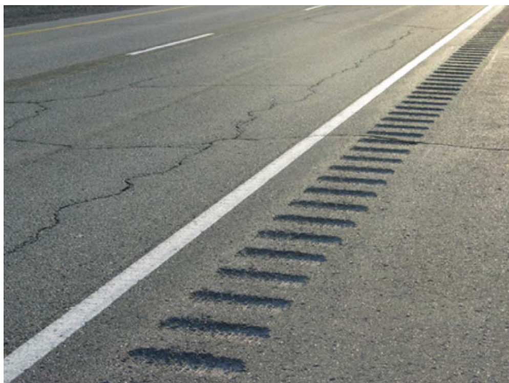
Prečno rezkan robni pas v opomin vozniku o nepravilnem položaju vozila (PIARC, str. 430)
