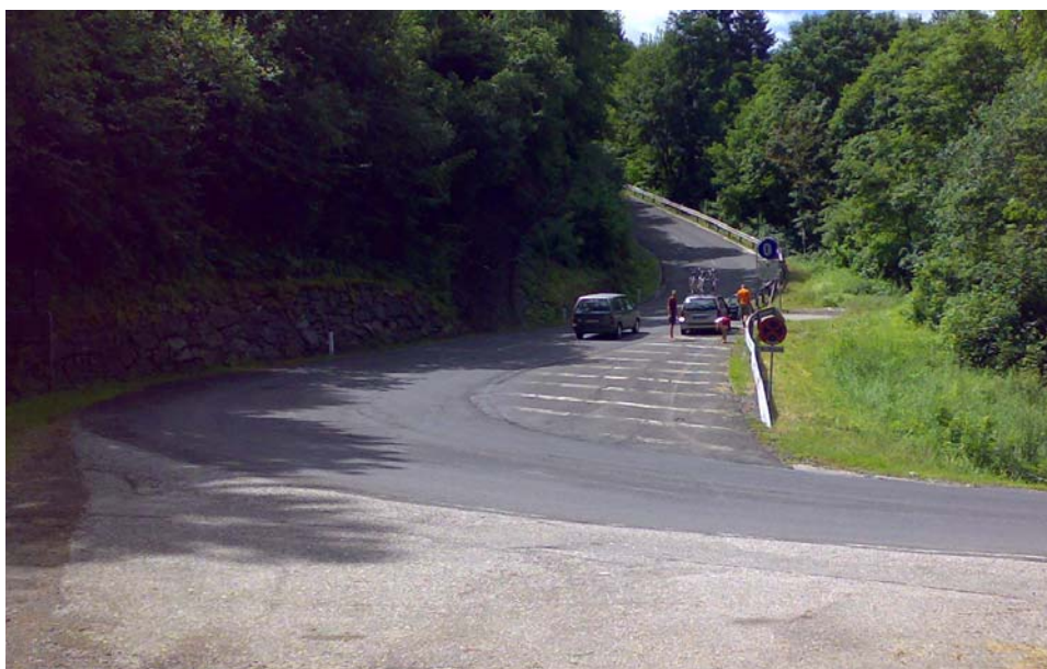
Slika 41: Neugodno speljan "odcep" za zasilni izvoz in nepravilno parkiran osebni avtomobil
