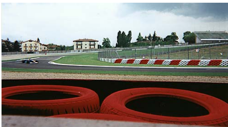
Slika 3: Zaščitna ograja iz avtomobilskih gum za izletno cono (Google Earth picture)
