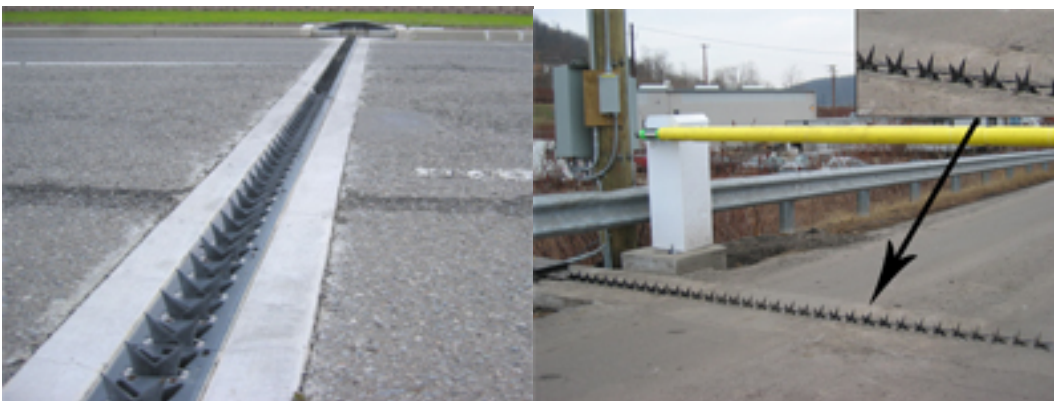
Bodice vgrajene v vozišče (dvignjene) (iskalnik Google, Emergency stop)
