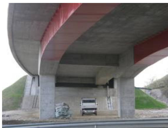
Slika 2: Pogled nadvoza od spodaj
