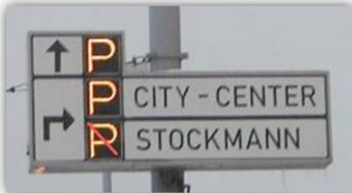
Slika: Prikazovanje statusa parkirnih površin s pomočjo piktogramov ( www.hel2.fi/liikenteenohjaus/eng/parking_guidance.asp )
