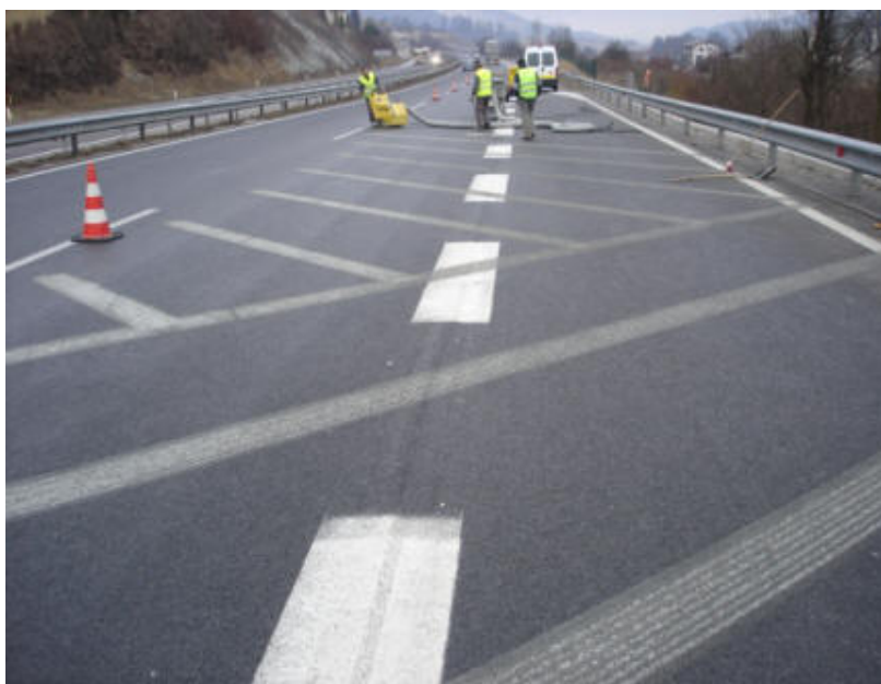
Slika 21: Vrezovanje žlebičev v površino vozišča
