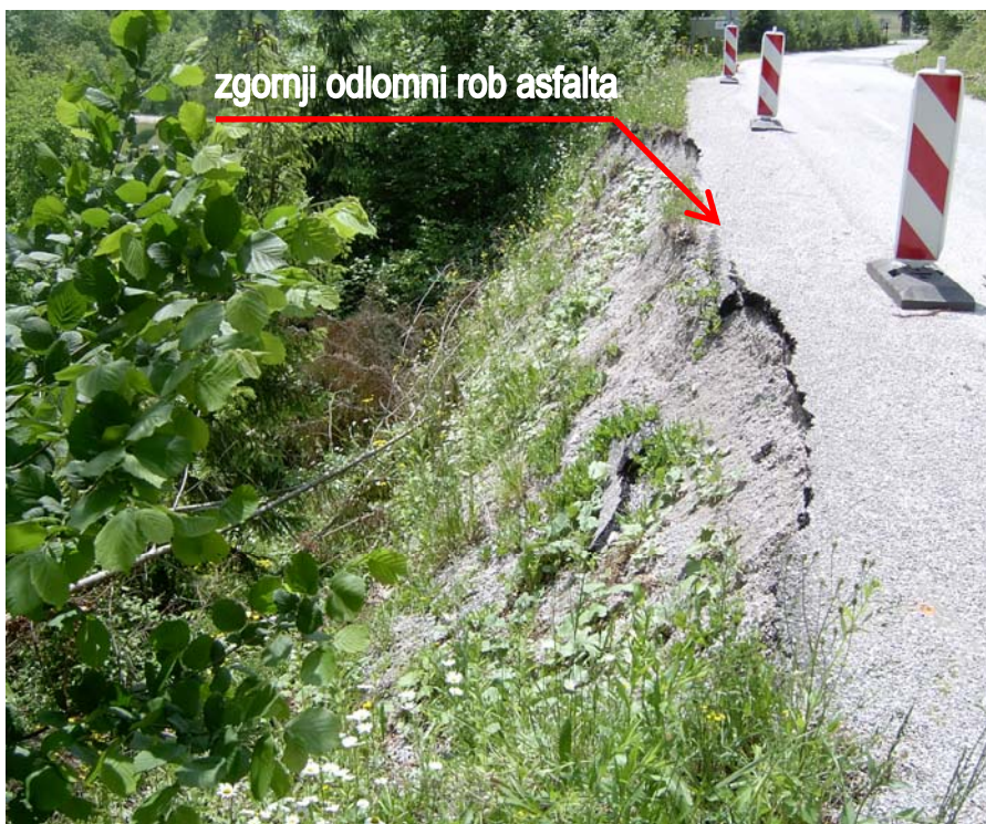
Slika 25: Fotografija USADA z odlomnim robom asfalta.
