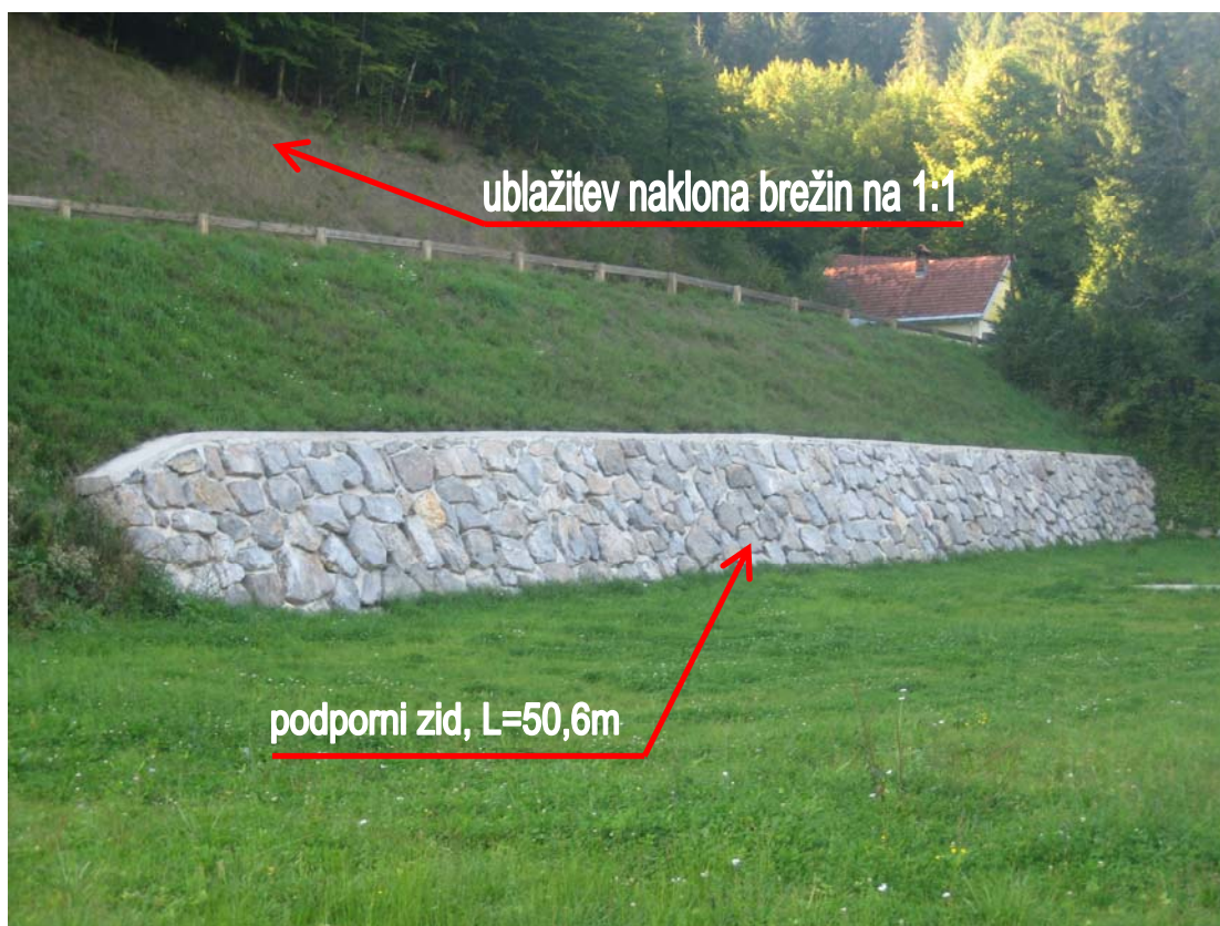
Slika 45: Prikaz saniranega stanja USADA s podpornim zidom.
