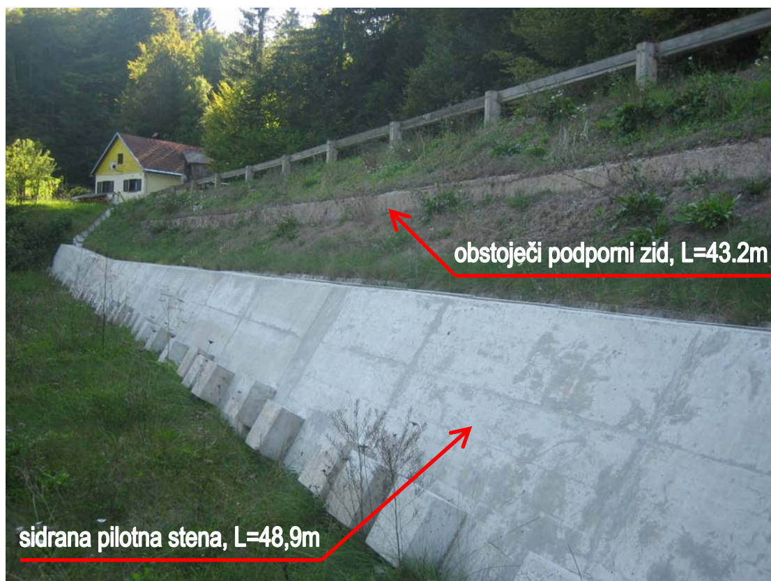
Slika 57: Prikaz saniranega stanja PLAZU s pilotno steno.
