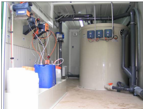
Slika 22: Enota UF in enota za čiščenje membran in nevtralizacijski bazen
