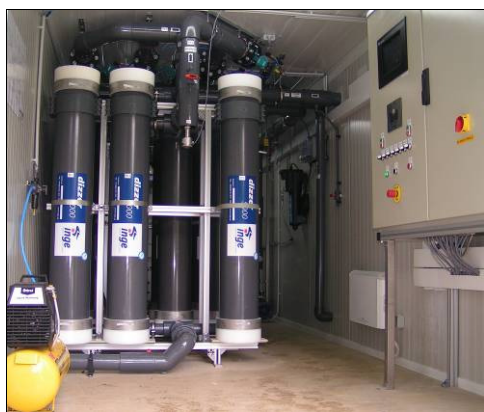
Slika 22: Enota UF in enota za čiščenje membran in nevtralizacijski bazen
