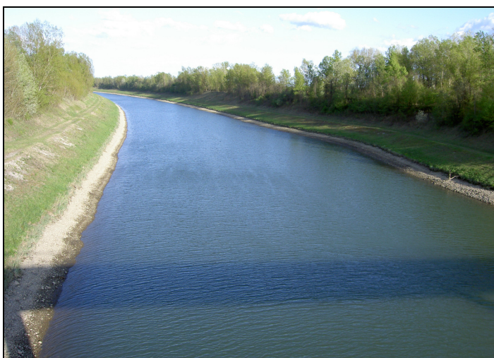
Slika 13: Kanal HC Formin
