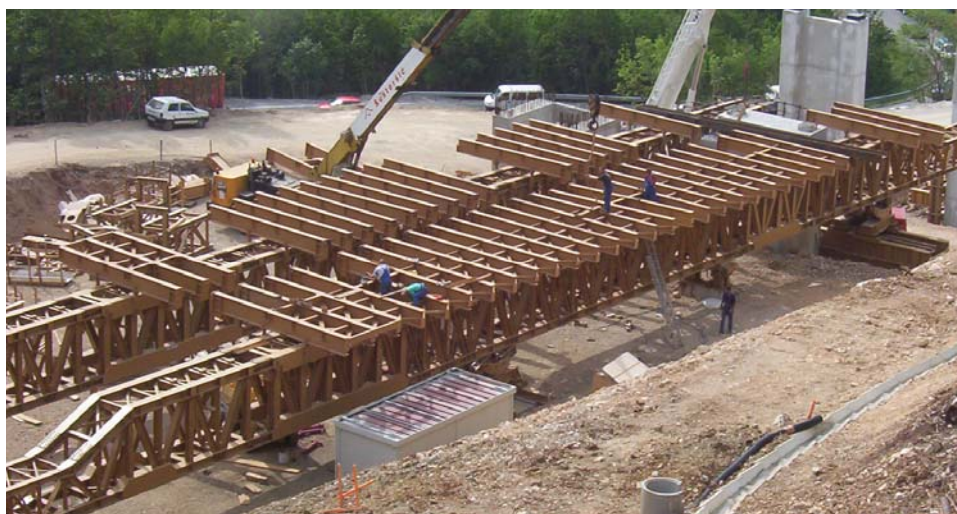
Slika 61: Montaža sekundarnih nosilcev na vrh glavnih vzdolžnih nosilcev
