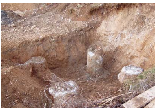
Slika 18: Izvedeni piloti
