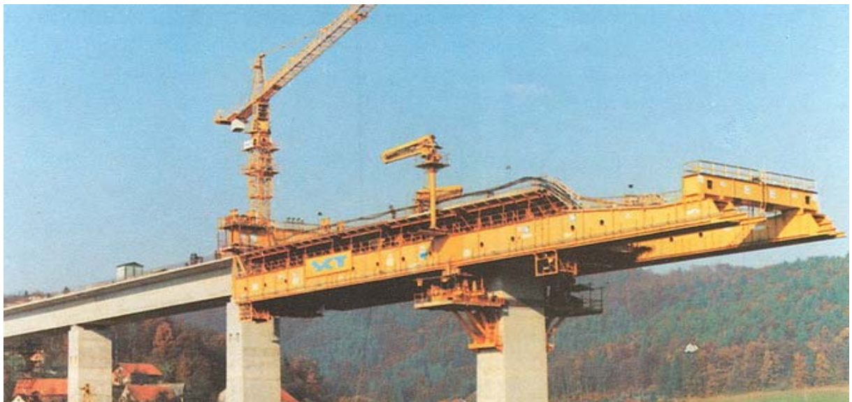
Slika 6: Pomični oder s spodnjo nosilno konstrukcijo in konzolnim podpiranjem (Vir: Dolenjska avtocesta: odsek Malence-Šmarje-Sap, Ministrstvo za promet in zveze RS, 1992)
