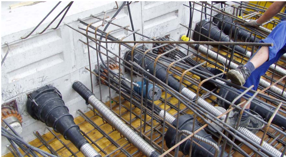
Slika 89: Podaljševanje kablov prekladne konstrukcije
