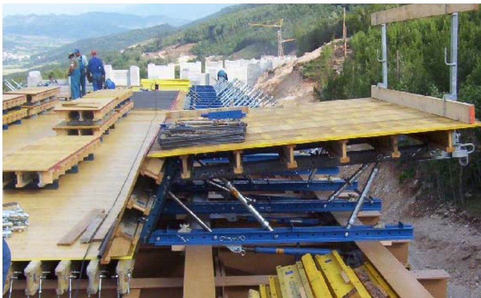
Slika 63: Nameščeni del desnega bočnega opaža
