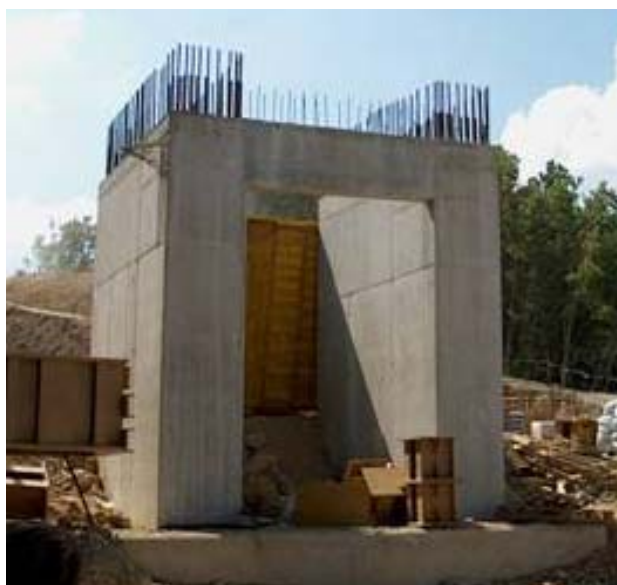
Slika 52: Prva faza izvedbe opornika. Zaradi možnosti premika pomičnega opažnega sistema mimo opornika so ti izdelani v večjih fazah.
