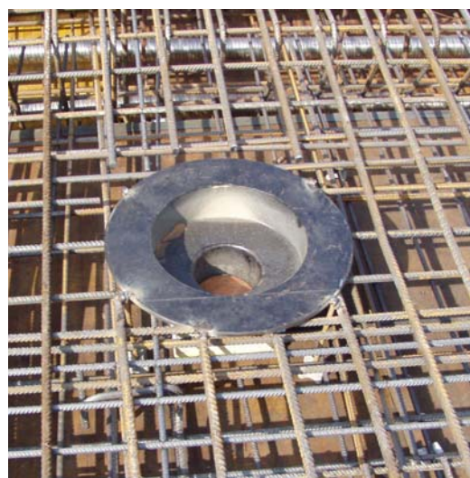
Slika 81: Vgrajen spodnji del izlivnika
