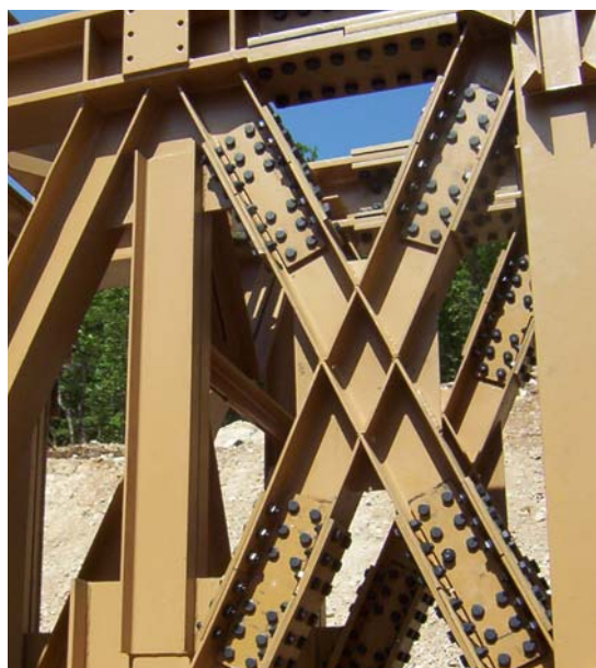
Slika 31: Spoj glavnega vzdolžnega nosilca
