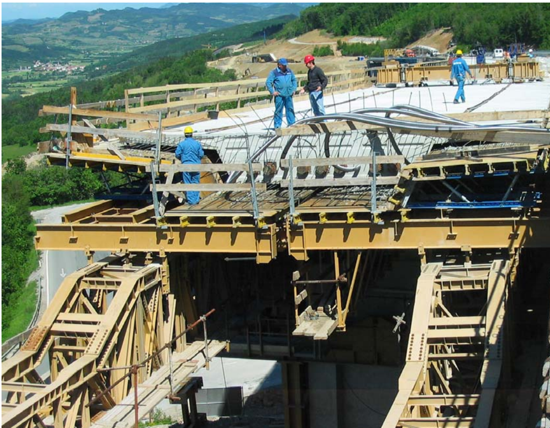
Slika 66: Razklenitev pomičnega opažnega sistema
