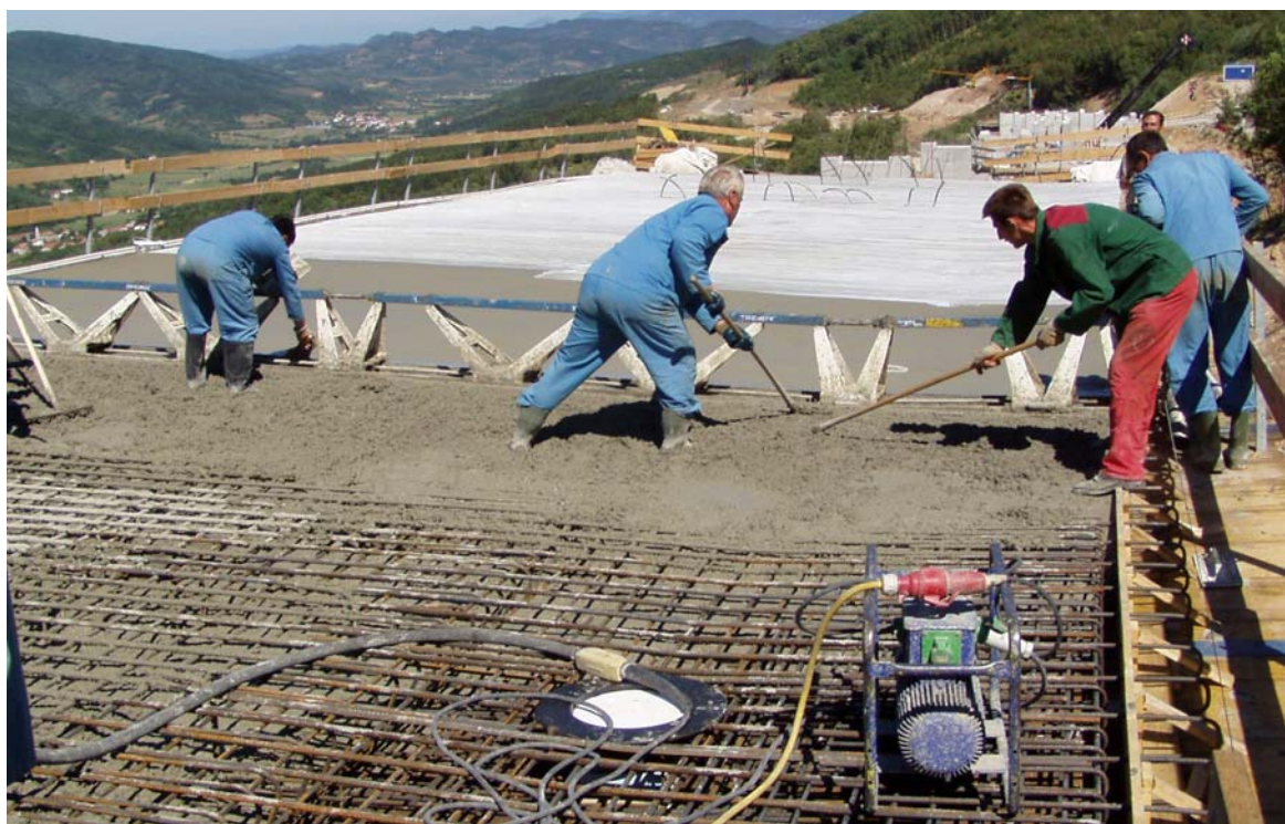
Slika 91: Potek betoniranja takta prekladne konstrukcije
