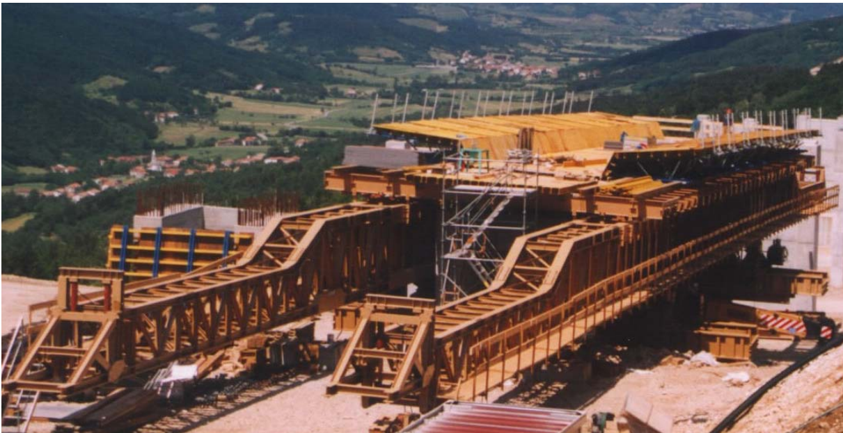
Slika 67: Pomični opažni sistem postavljen na mestu izdelave prvega takta desne prekladne konstrukcije
