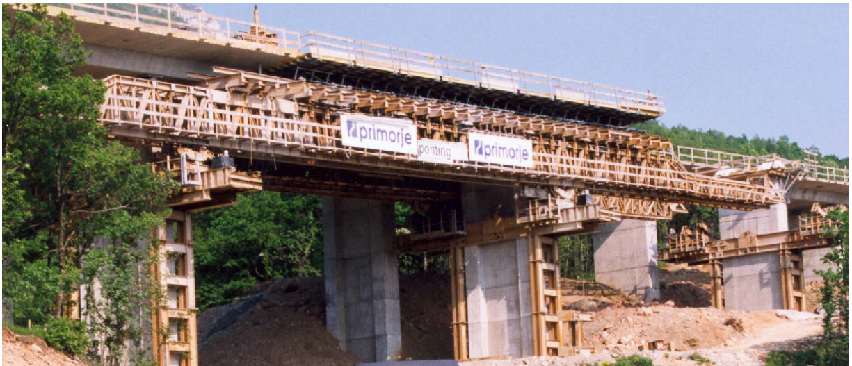
Slika 5: Pomični oder s spodnjo nosilno konstrukcijo, s podpiranjem s tal
