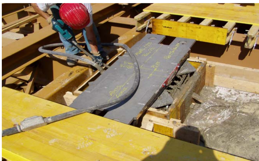
Slika 73: Vibriranje ležiščne blazine
