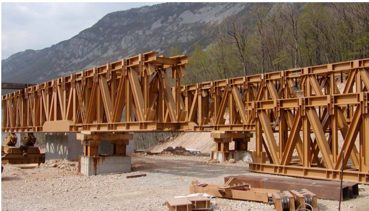
Slika 60: Montaža glavnih vzdolžnih nosilcev
