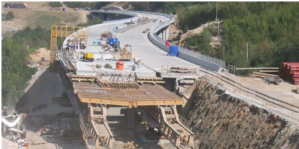
Slika 68: Pomični opažni sistem na koncu izdelave 22 takta leve prekladne konstrukcije
