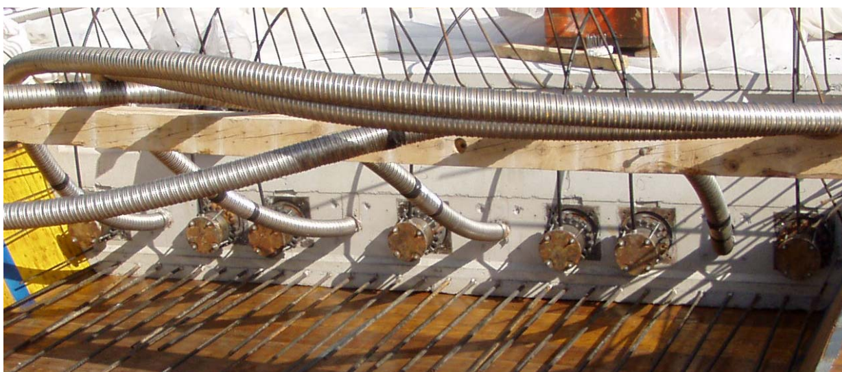
Slika 100: Nameščene injektirne kape med injektiranjem
