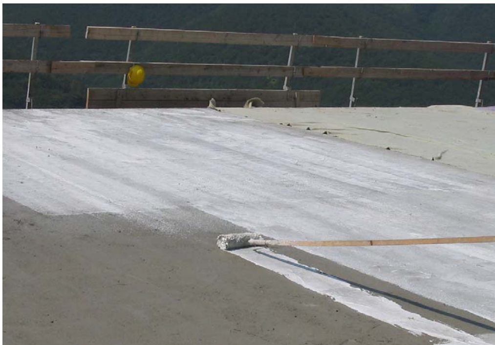
Slika 92: Izvedba zaščite betonske površine v poletnih mesecih pred izgubo vlage
