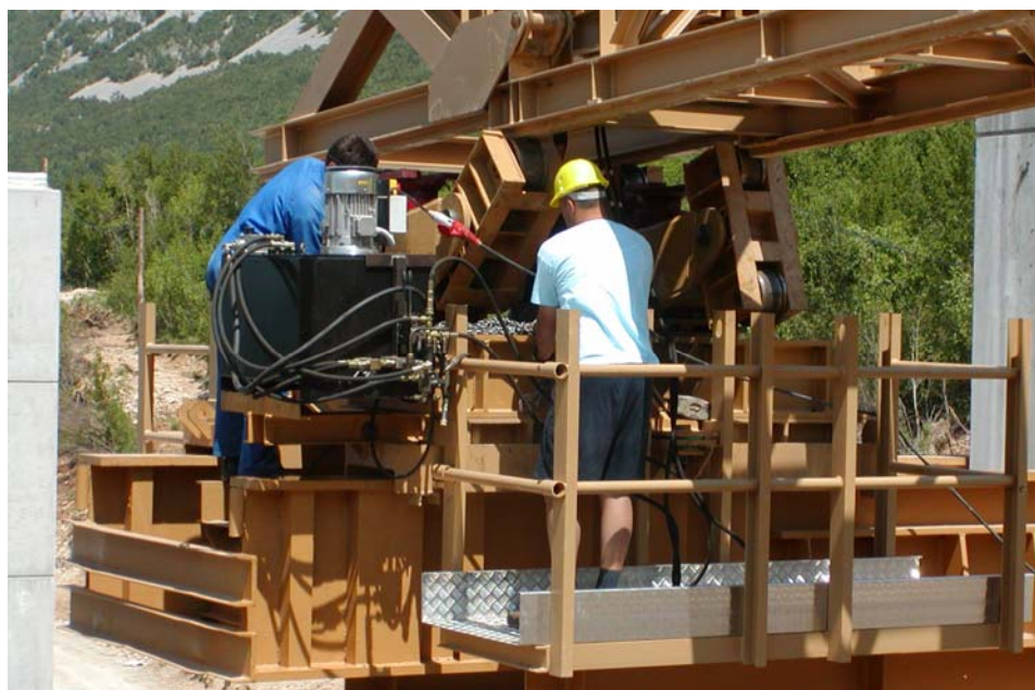
Slika 62: Nameščanje hidravličnih instalacij
