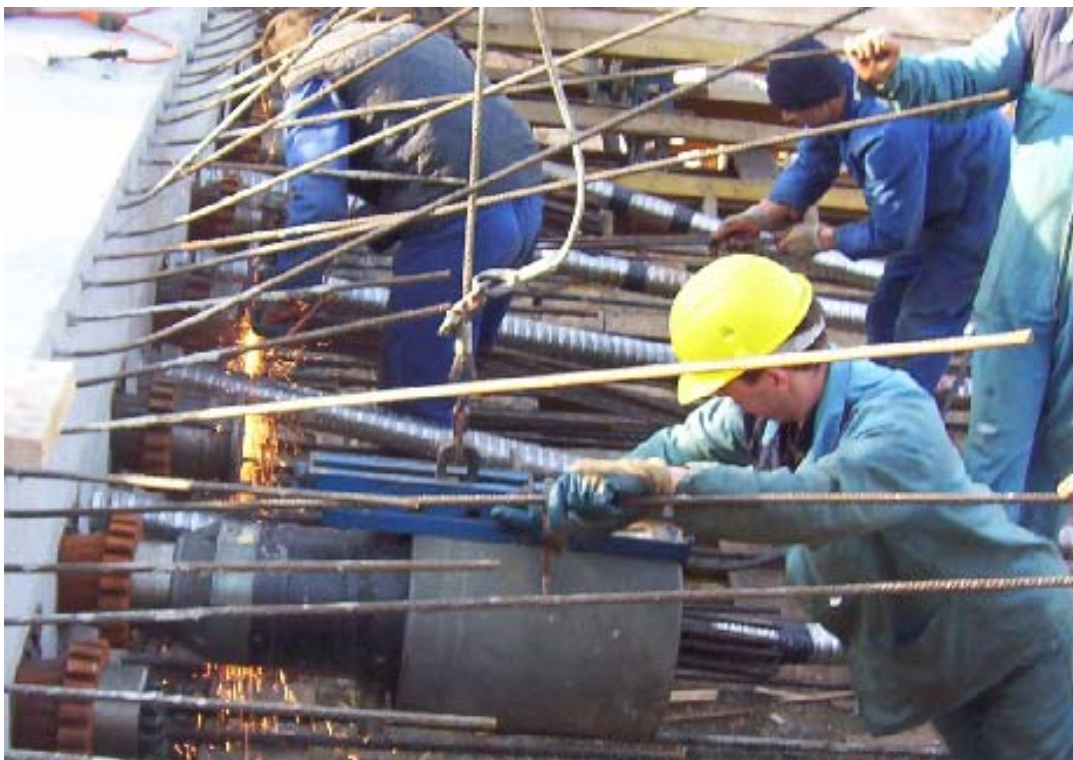
Slika 99: Napenjanje kablov
