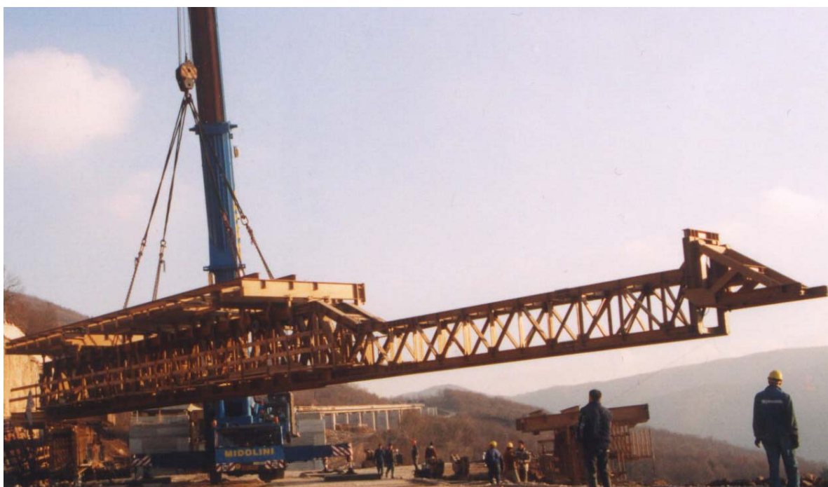
Slika 102: Premontaža dela pomičnega opažnega sistema
