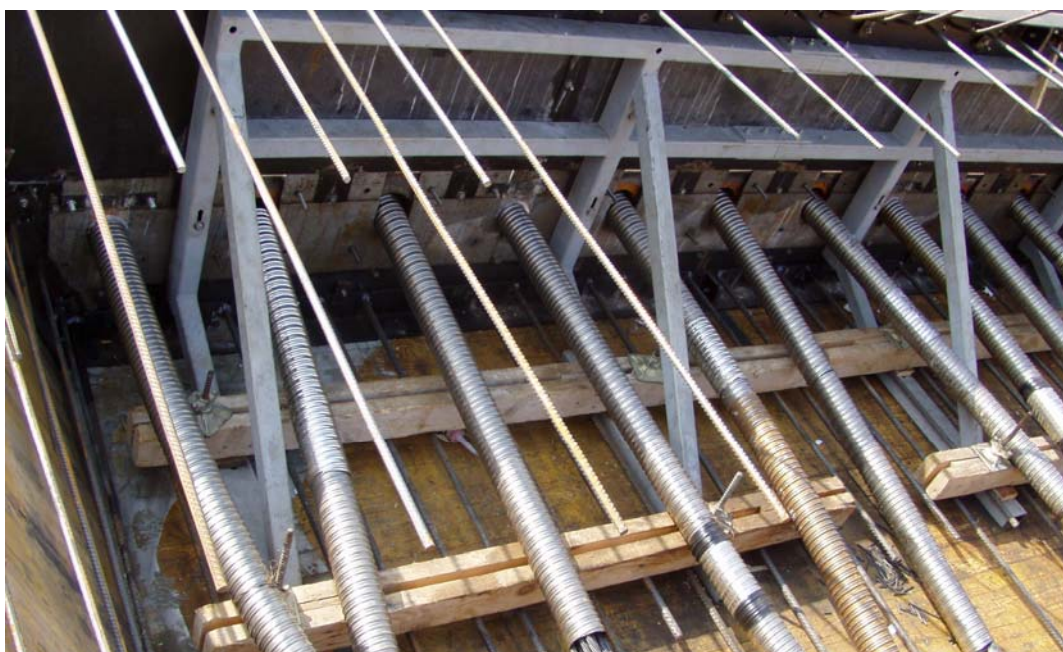
Slika 50: Čelna zapora, nameščena na konec takta prekladne konstrukcije
