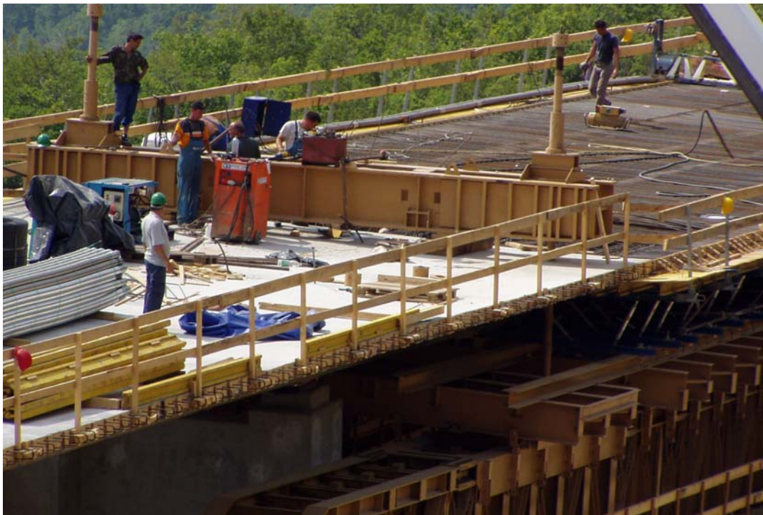
Slika 34: Nameščen jarem na konec prehodno zabetoniranega takta prekladne konstrukcije
