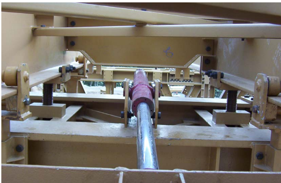
Slika 39: Horizontalni hidravlični cilindri za premik sekundarnih nosilcev
