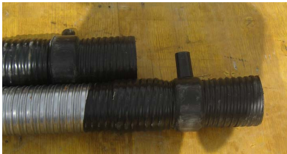
Slika 85: Nameščen plastični del za injektiranje - oddušna cev
