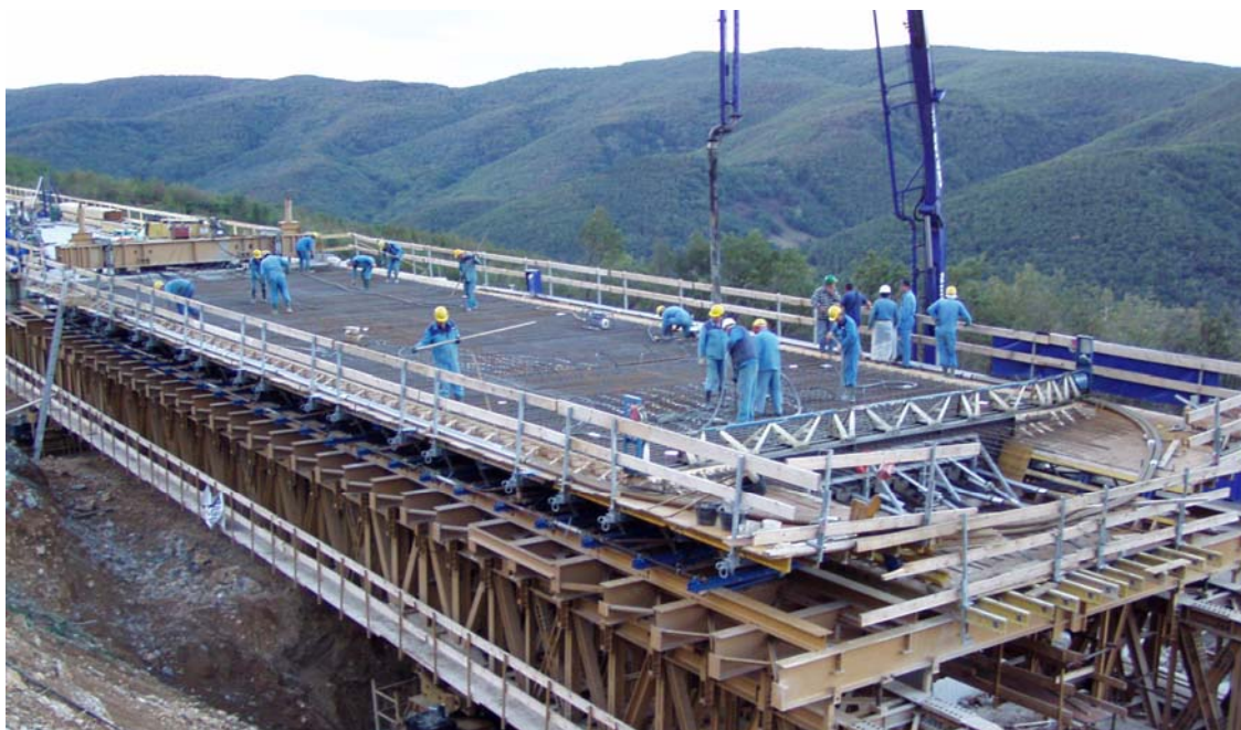
Slika 90: Priprave na betoniranje takta prekladne konstrukcije
