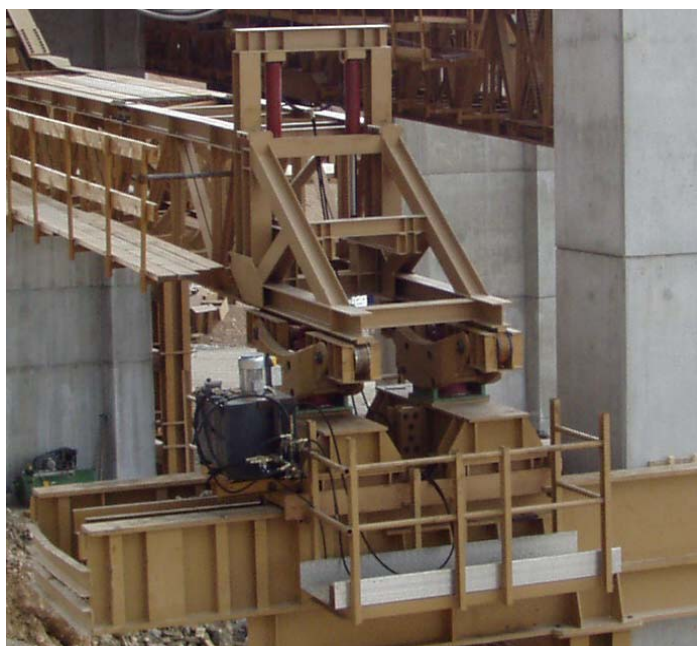
Slika 32: Konica kljuna naleže na voziček
