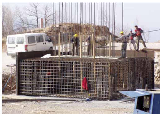
Slika 19: Polaganje armature temeljne blazine
