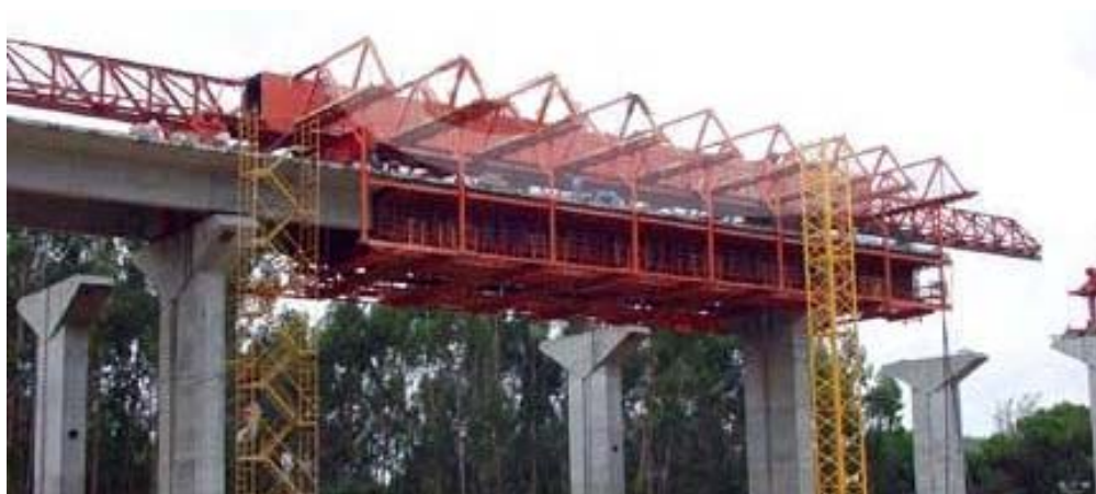
Slika 4: Pomični oder z zgornjo nosilno konstrukcijo
