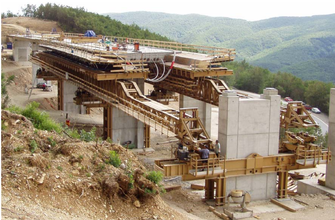
Slika 24: Vzdolžni pomik pomičnega opažnega sistema pri viaduktu Šumljak
