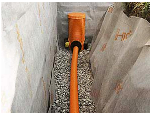
Slika 24: V gramoz položena drenafna cev in geotekstil ob straneh (Din 4095, Tab. 1).
