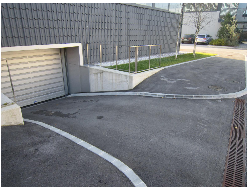
Slika 18: Vhodna rampa, kjer je se je voda prelila v klet objekta (Rok Tanko, 7.7.2011).
