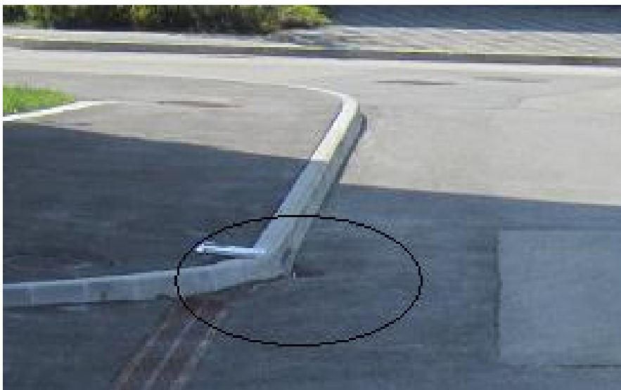
Slika 20: Vto ni ja-ek s elnim vtokom (Rok Tanko, 7.7.2011).
