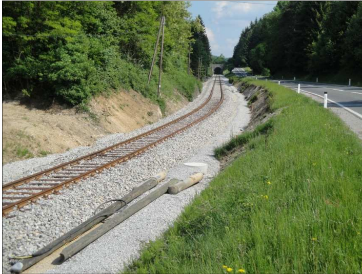
Slika 20: Novi nosilni drogovi za samonosilni optični in TK kabel (Vir 20: Škufca, 2011)
