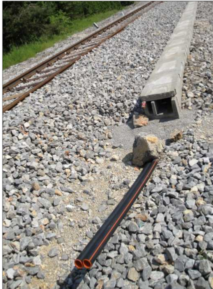
Slika 19: Betonska kineta za SV napeljavo v Velikih Laščah (Vir 19: Škufca, 2011)
