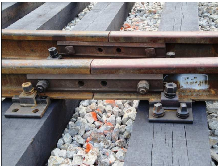
Slika 17: Novo vgrajene tirnice s K sistemom pritrditve na nove prage (Vir 17: Škufca, 2011)
