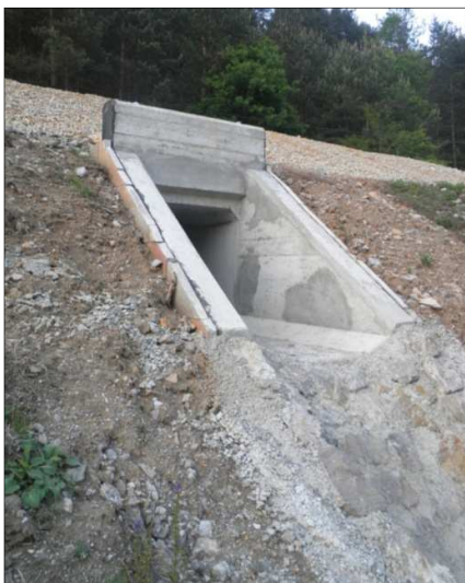
Slika 21: Novi montažni propust na odprti prog Velike Lašče–Ortnek (Vir 21: Škufca, 2011)
