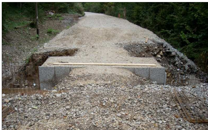
Slika 22: Nov AB propust na progi pri Predolah v fazi gradnje (Vir 22: Škufca, 2008)
