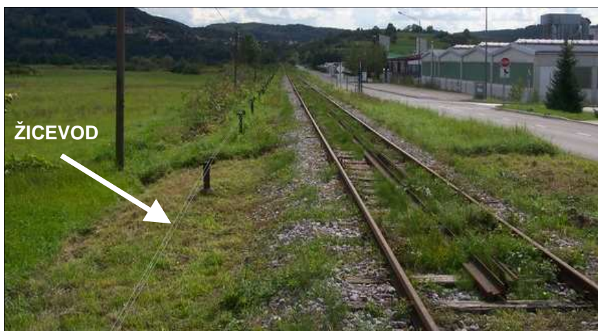
Slika 10: Žicevod ob progi Grosuplja–Spodnja Slivnica (Vir 10: Škufca, 2008)
