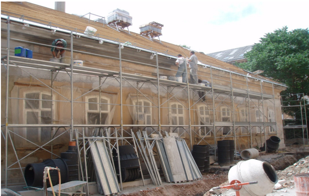
Slika 3: Južni del objekta med prenovo
