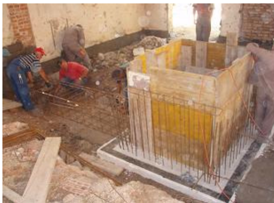
Slika 6: Gradnja dvigalnega jaška levo in gradbena jama za dvigalni jašek desno
