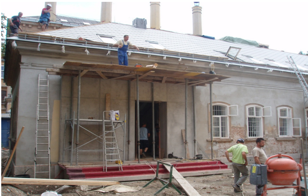
Slika 4: Severni del objekta med prenovo
