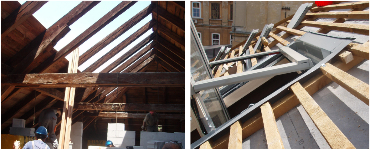
Slika 2: Prenova strehe – odstranitev letev levo in nameščanje svetlobnikov desno
